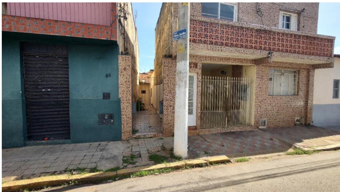
fachada do imóvel – Rua Silva Jardim, 5
