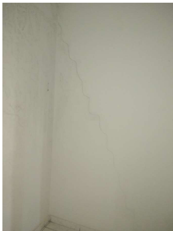
Figura 49 - Vista interna sobrado
