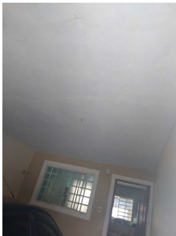
Figura 37 - Vista interna sobrado
