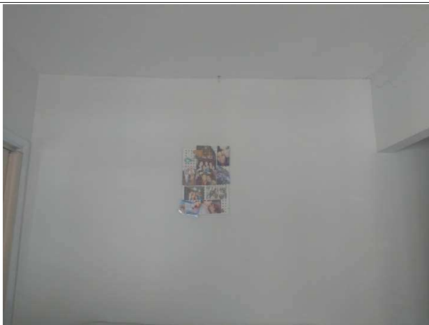
Figura 10 - Vista interna edícula
