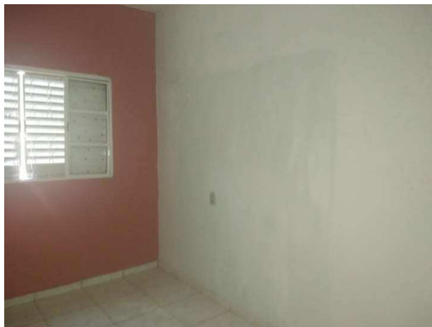
Figura 50 - Vista interna sobrado
