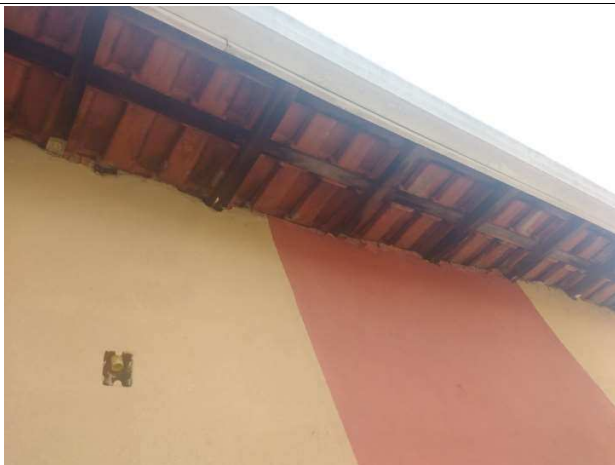
Figura 70 - Vista interna sobrado
