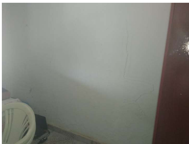
Figura 25 - Vista interna edícula
