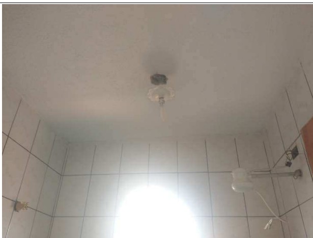
Figura 58 - Vista interna sobrado
