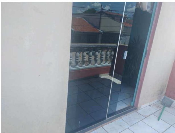
Figura 71 - Vista interna sobrado
