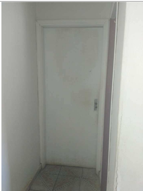
Figura 17 - Vista interna edícula
