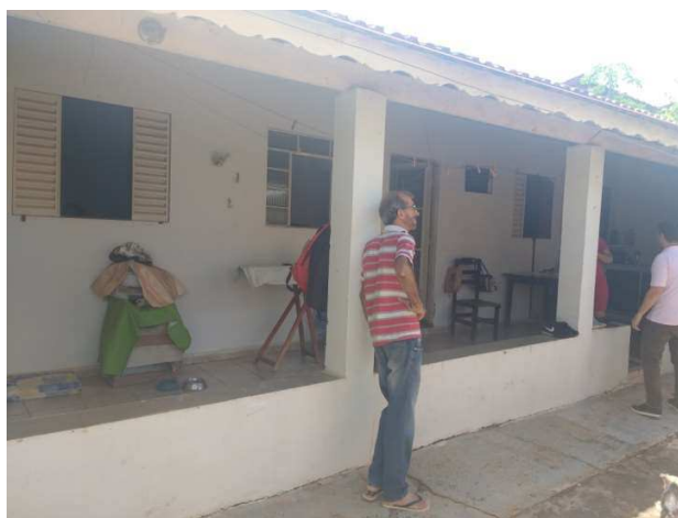
Figura 5 - Vista externa edícula
