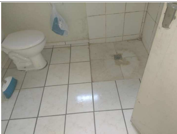
Figura 82 - Vista interna sobrado
