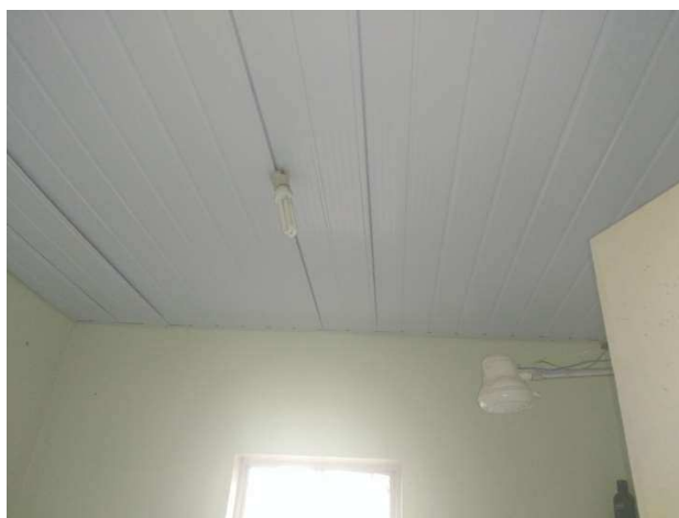
Figura 81 - Vista interna sobrado
