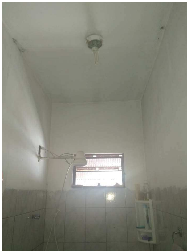
Figura 14 - Vista interna edícula
