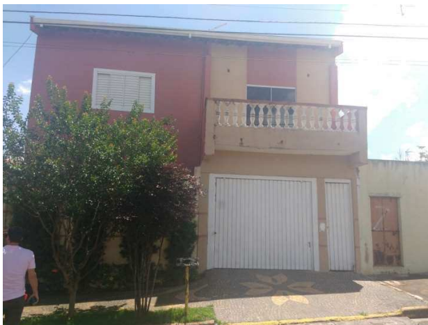
Figura 1 - Vista frontal do imóvel
