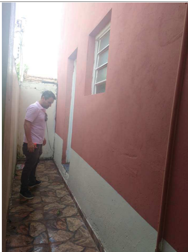
Figura 73 - Vista interna sobrado
