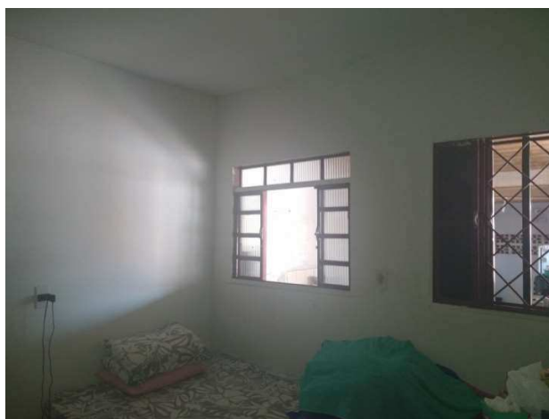
Figura 18 - Vista interna edícula
