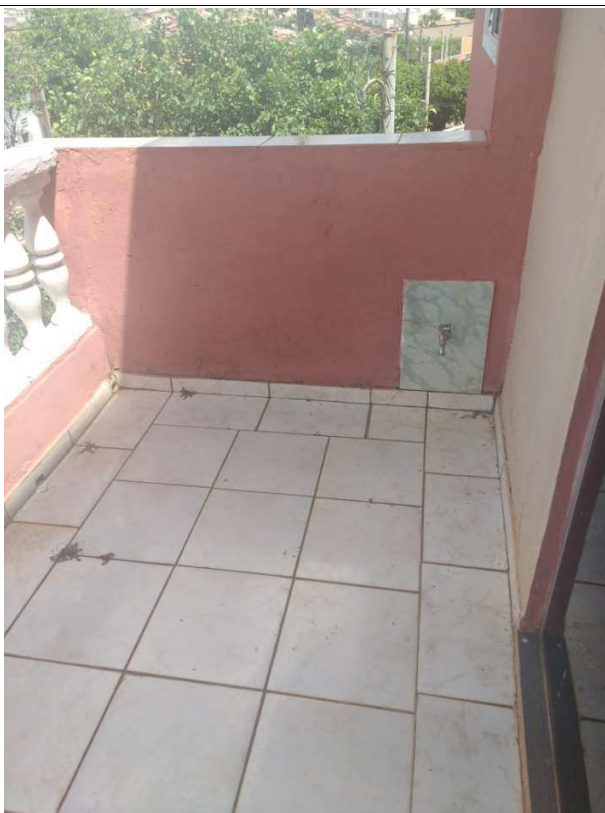
Figura 68 - Vista interna sobrado
