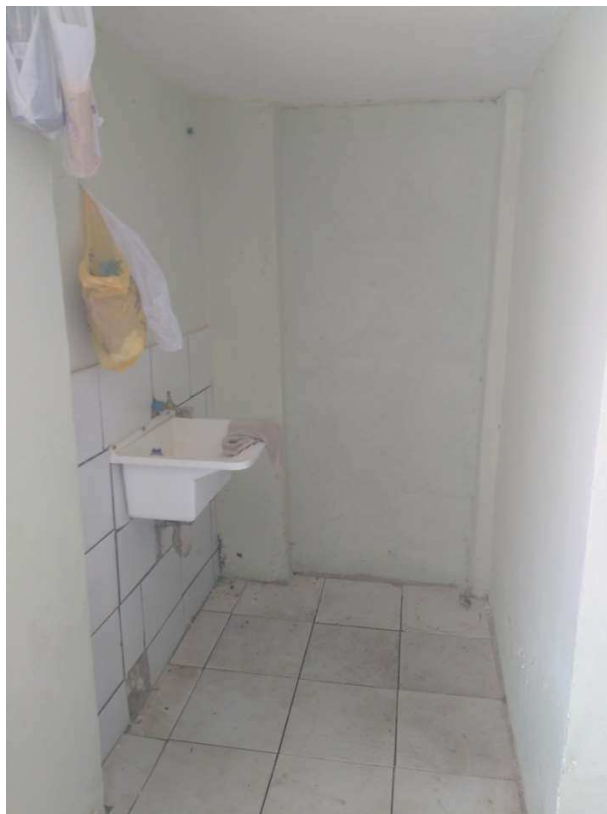
Figura 87 - Vista interna sobrado
