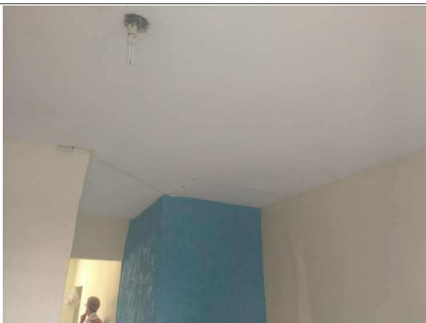
Figura 75 - Vista interna sobrado
