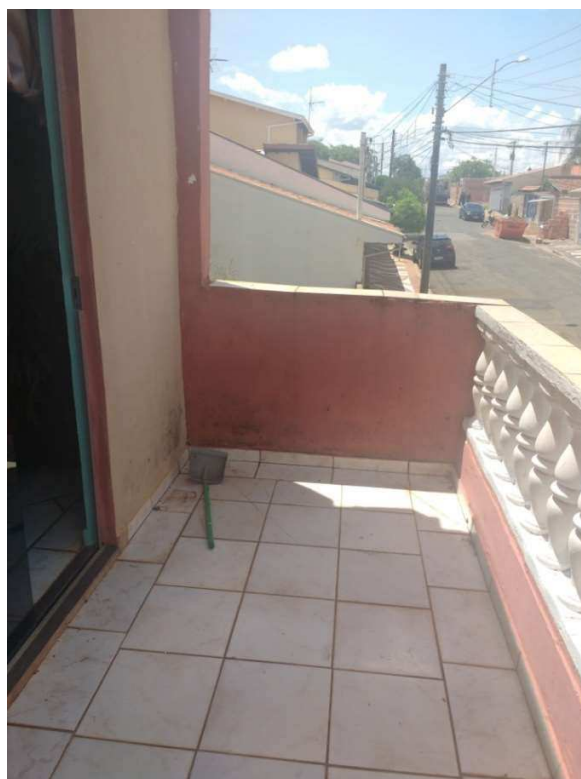
Figura 69 - Vista interna sobrado
