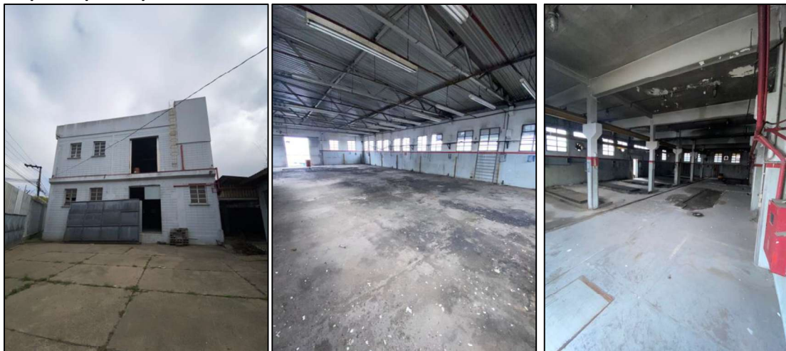
Galpão 2, piso superior e inferior:
