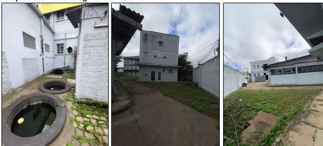
Estação tratamento de água e area externa:
