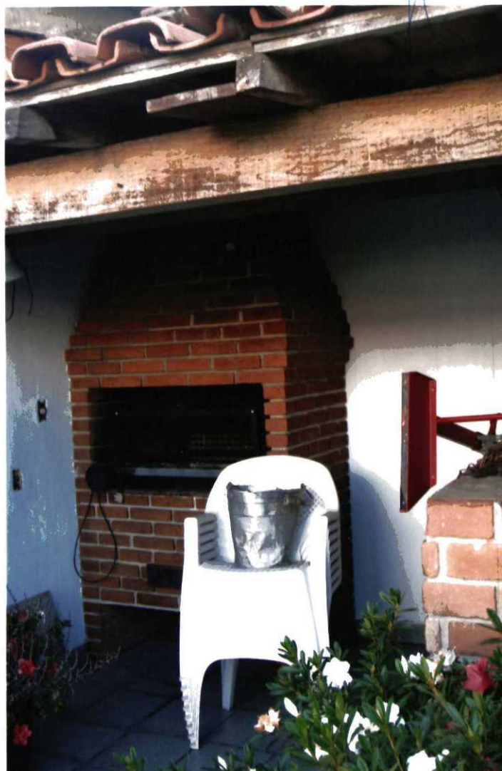
VISTA DA COBERTURA COM CHURRASQUEIRA.
