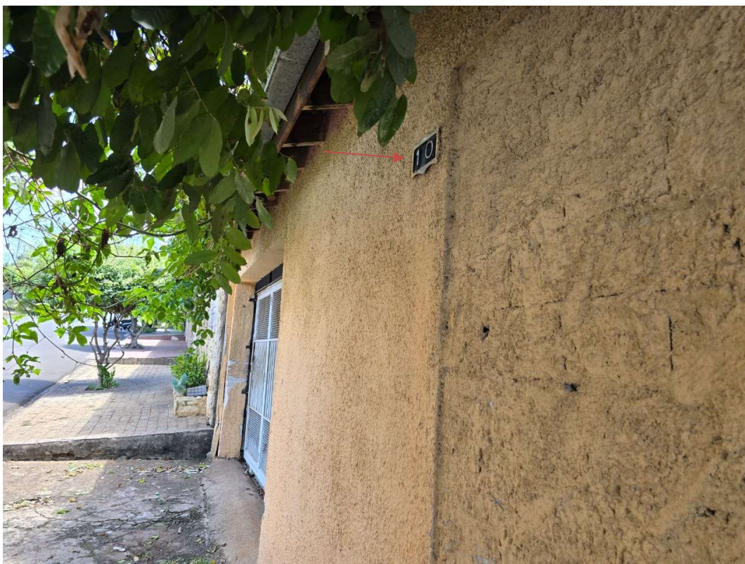
Foto 15: Calçada e numeração do imóvel avaliando.
