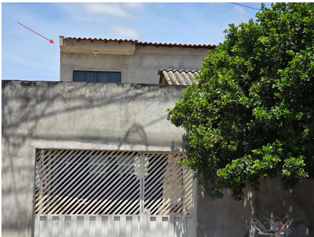
Foto 12: Imóvel avaliando visto da rua de trás, onde é possível avistar uma janela no segundo pavimento.
