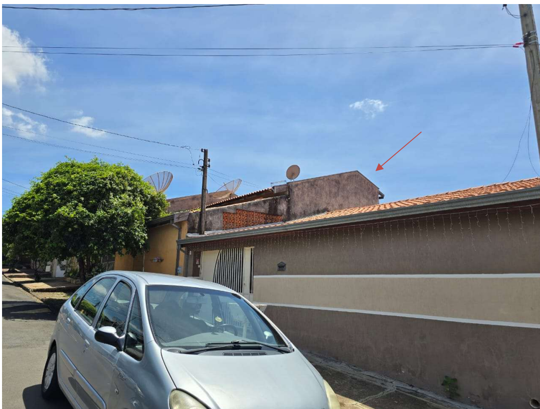
Foto 9: Vista da lateral ao qual pode-se perceber um segundo pavimento na edificação.
