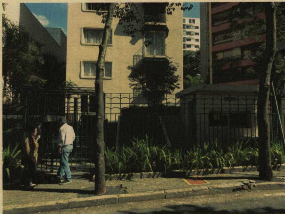
VISTA DA ENTRADA DO EDIFÍCIO.
