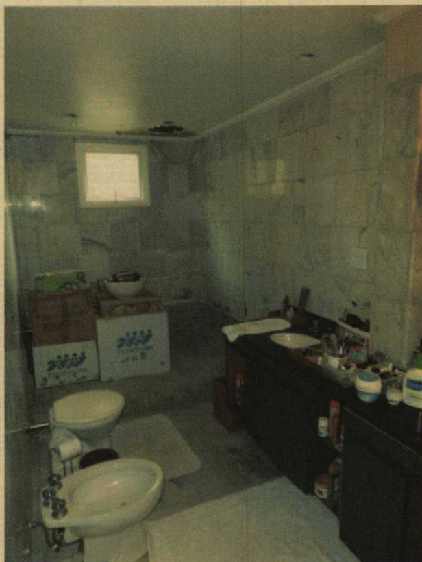
VISTA DO BANHEIRO DO TERCEIRO DORMITÓRIO.
