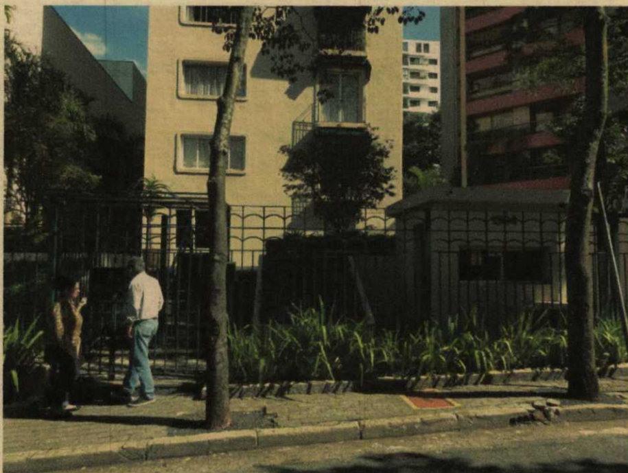
VISTA DA ENTRADA DO EDIFÍCIO.
