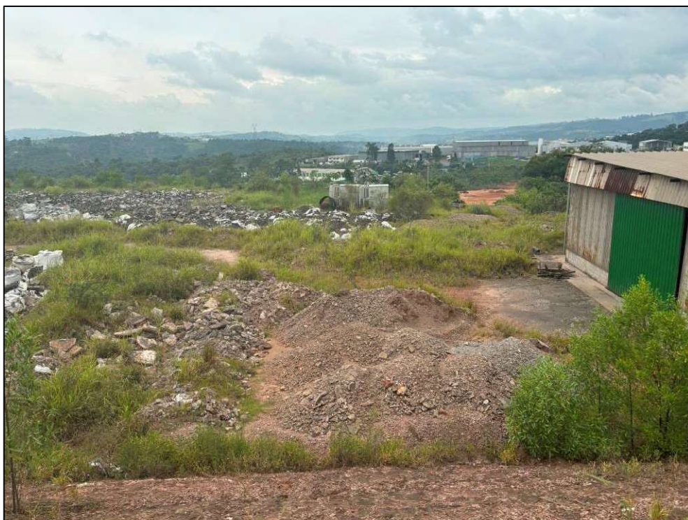
Vista geral do terreno do imóvel avaliando
