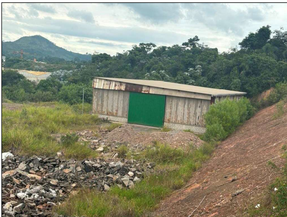
Vista geral do galpão existente no imóvel avaliando
