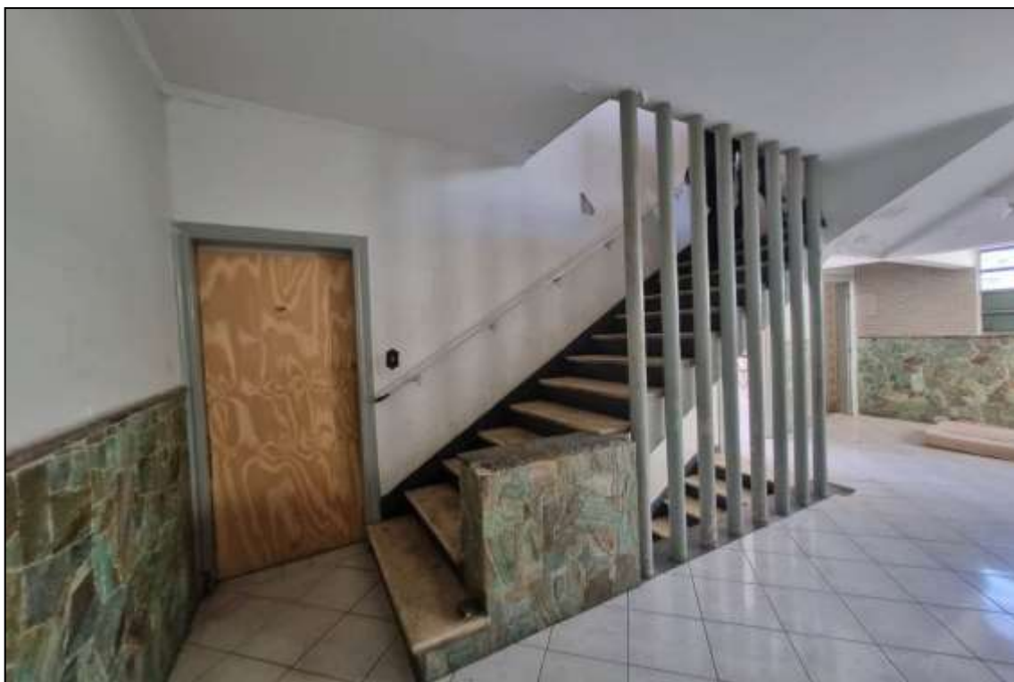
Foto nº 15: Vista da escadaria de acesso ao último pavimento da edificação.
