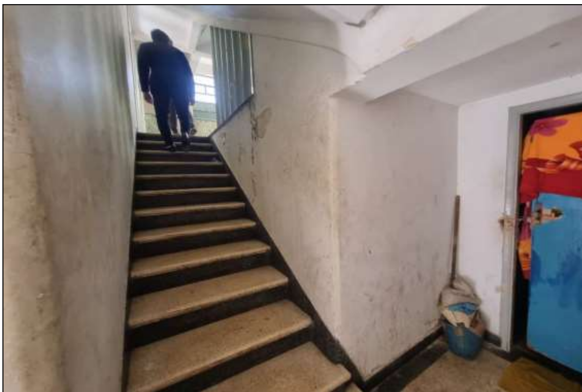
Foto nº 10: Vista da escadaria de acesso interna aos pavimentos superiores da edificação.
