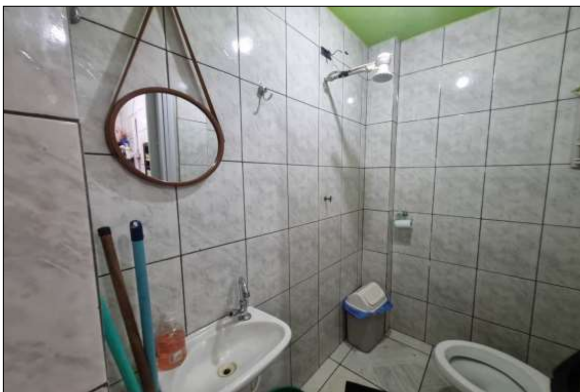
Foto nº 6: Vista do banheiro. Suas principais características construtivas são: piso cerâmico, paredes azulejadas até o teto e forro em laje.
