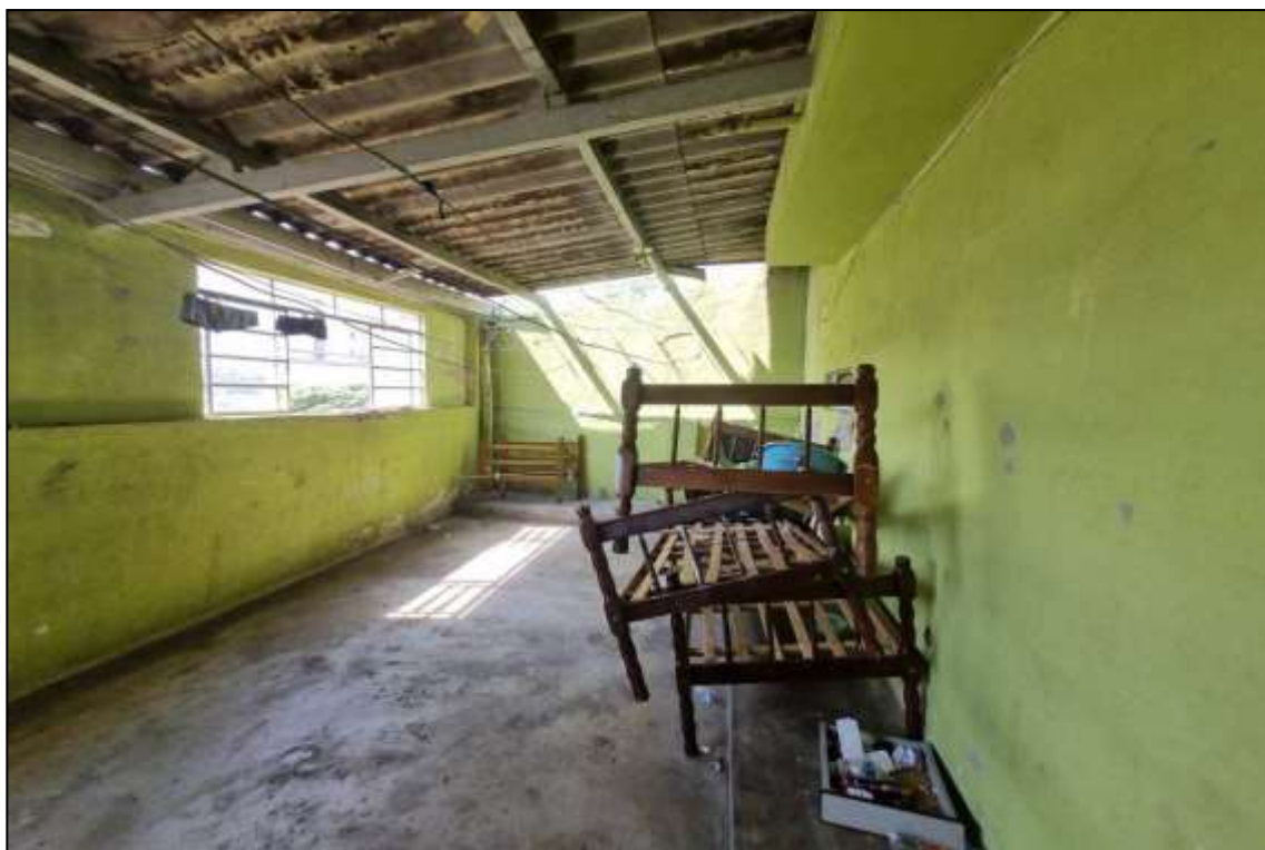
Foto nº 18: Vista da área externa coberta com telhas de fibrocimento e apoiadas sobre estrutura de madeira, no último pavimento da edificação.
