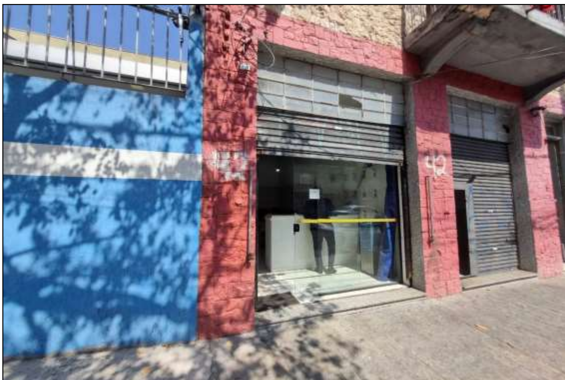
Foto nº 4: Vista do acesso para o escritório existente no pavimento térreo da edificação.
