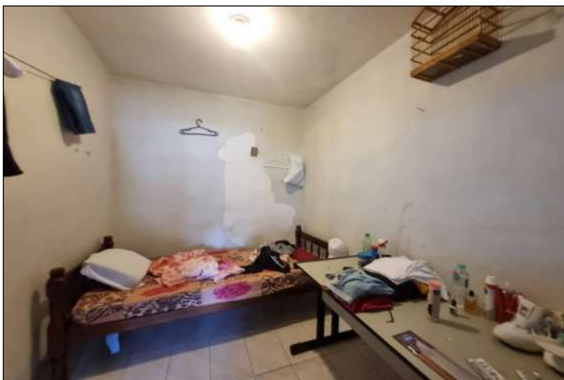
Foto nº 17: Vista de um dormitório. Suas principais características construtivas são: piso cerâmico, paredes revestidas em massa corrida pintada em látex e forro em laje.
