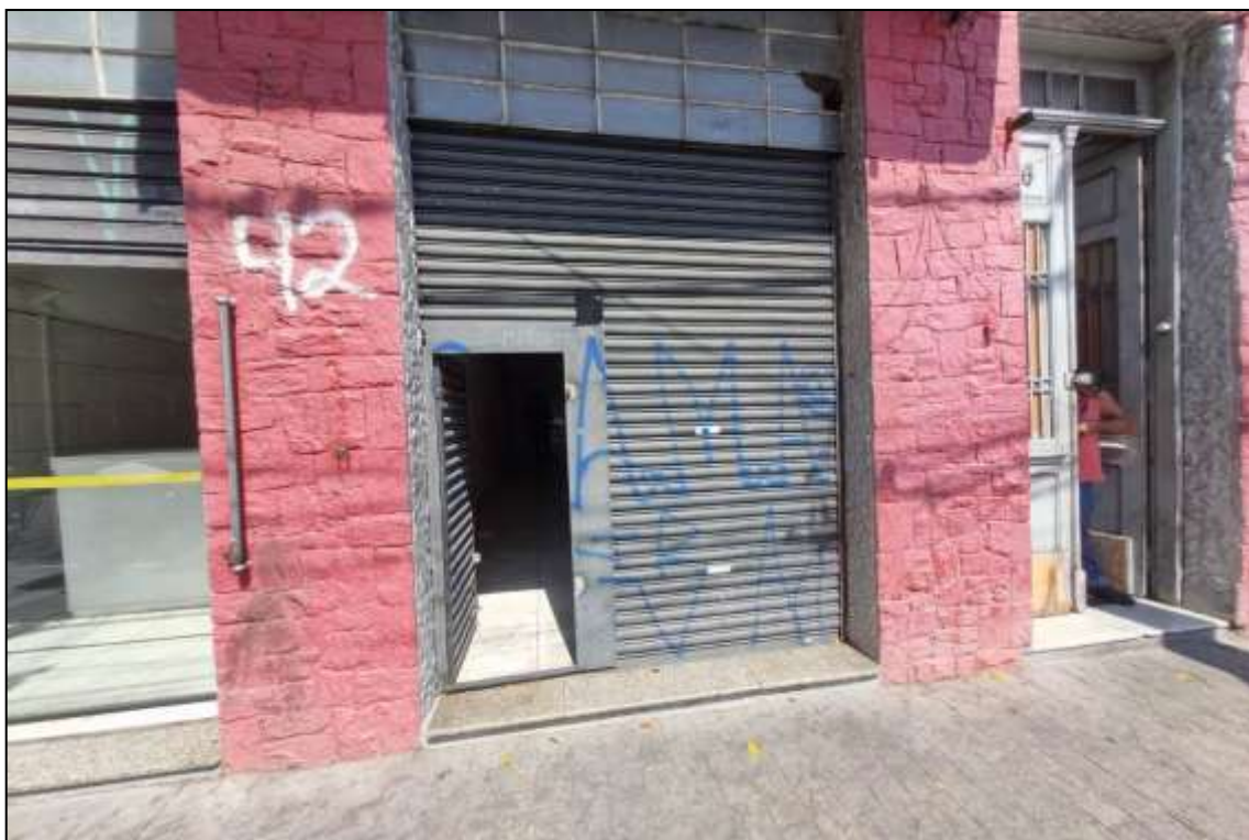
Foto nº 7: Vista do acesso para a área desocupada no pavimento térreo.
