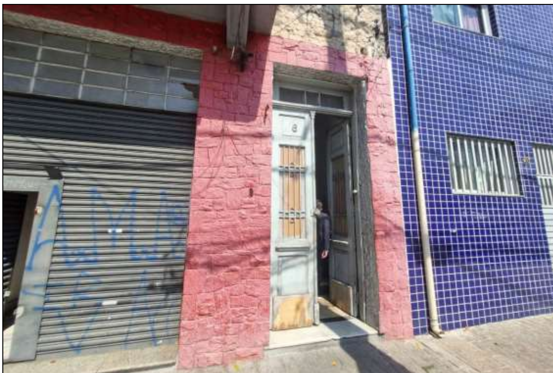
Foto nº 9: Vista do acesso para os pavimentos superiores da edificação.
