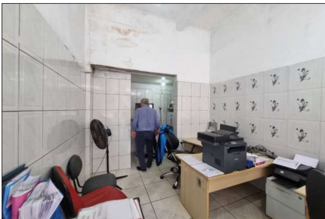
Foto nº 5: Vista interna do escritório. Suas principais características construtivas são: piso cerâmico, paredes parte azulejadas e parte revestidas em massa corrida pintada em látex e forro em laje.
