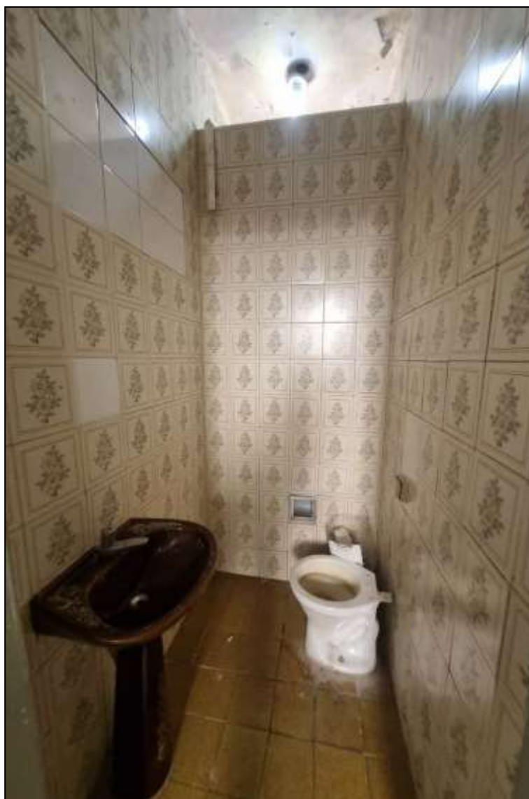
Foto nº 13: Vista do banheiro. Suas principais características construtivas são: piso cerâmico, paredes azulejadas até o teto e forro em laje.
