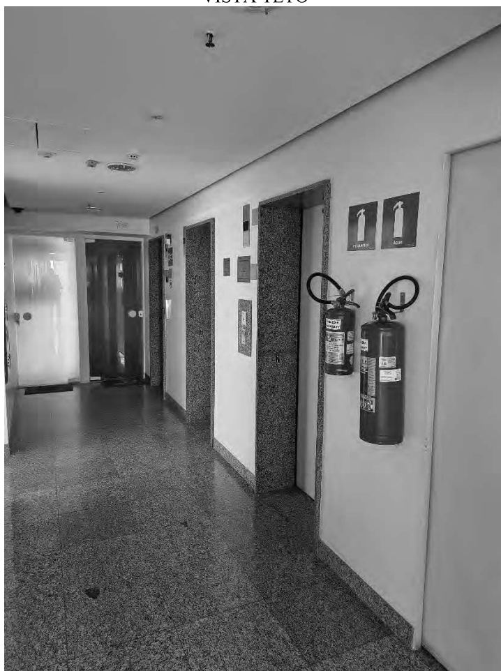
VISTA CORREDOR DO 7º ANDAR
