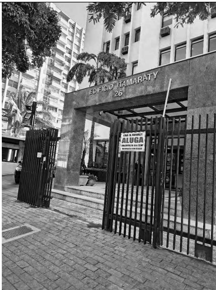
VISTA DO PRÉDIO
