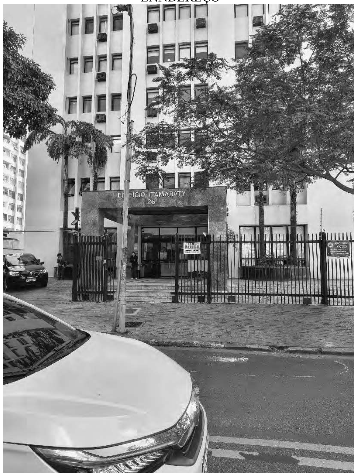
FRENTE DO EDIFÍCIO
