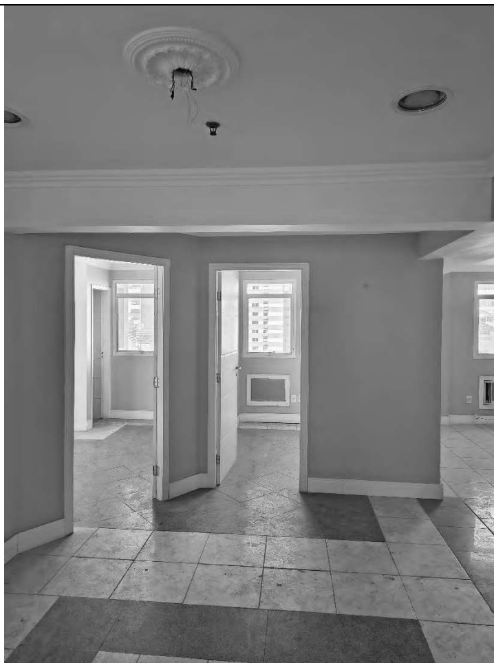
VISTA PELO LADO DIREIRO DUAS SALAS UMA COM BANHEIRO
