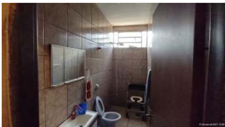
FOTO 07 – Outra vista interna do imóvel em questão.
