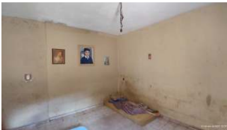
FOTO 06 – Outra vista interna do imóvel em questão.
