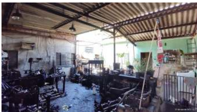
FOTO 03 – Outra vista externa do imóvel em questão.
