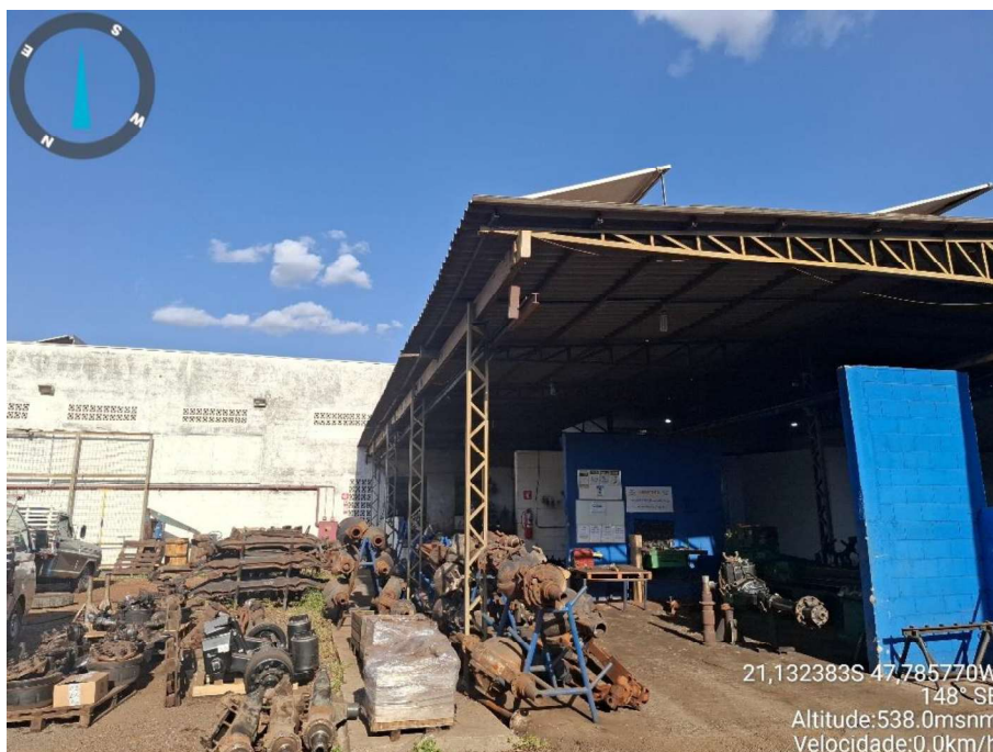
Foto 4 - Vista parcial da cobertura implantada no imóvel objeto
