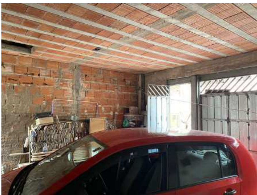
Fotos que demonstram a garagem frontal ainda sem acabamento e pintura.
