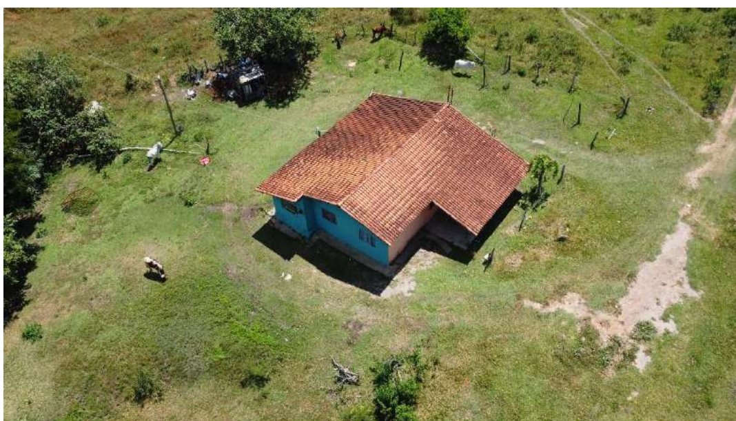
Foto 23 – Vista do Imóvel Avaliando 2.
