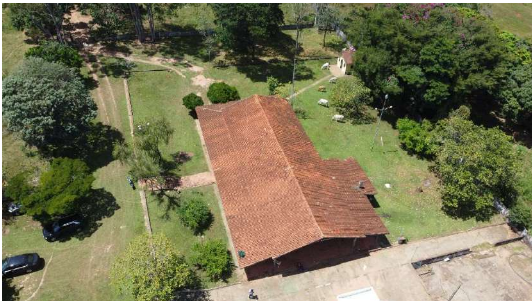
Foto 14 – Vista do Imóvel Avaliando 2.
