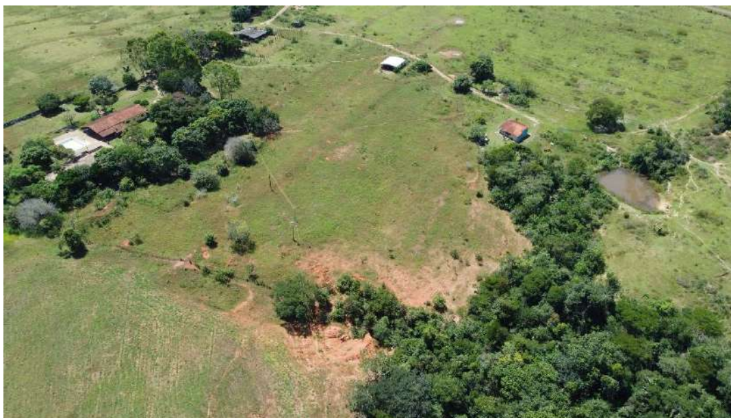
Foto 20 – Vista do Imóvel Avaliando 2.
