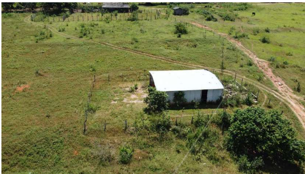
Foto 24 – Vista do Imóvel Avaliando 2.
