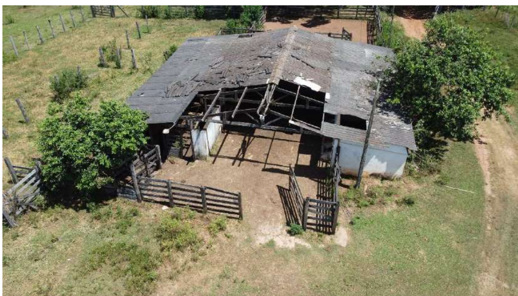
Foto 25 – Vista do Imóvel Avaliando 2.
