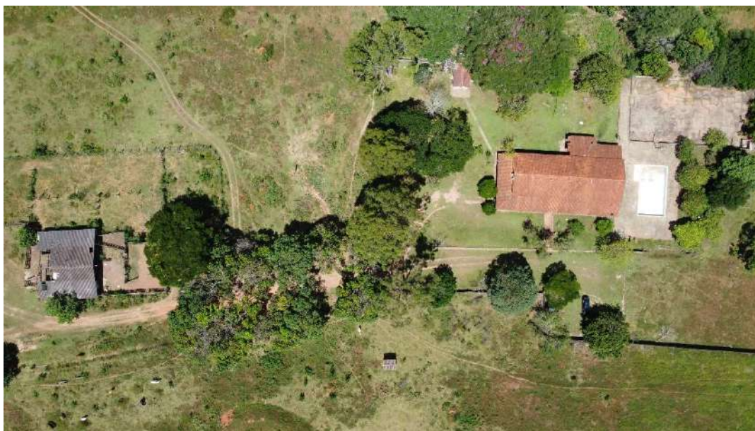
Foto 26 – Vista do Imóvel Avaliando 2.
