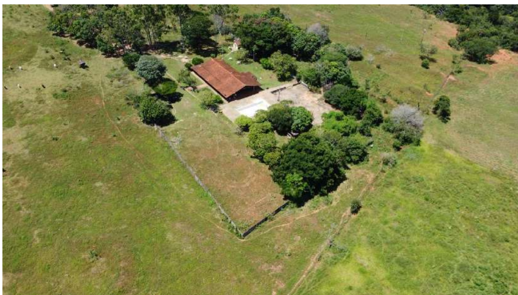
Foto 17 – Vista do Imóvel Avaliando 2.
