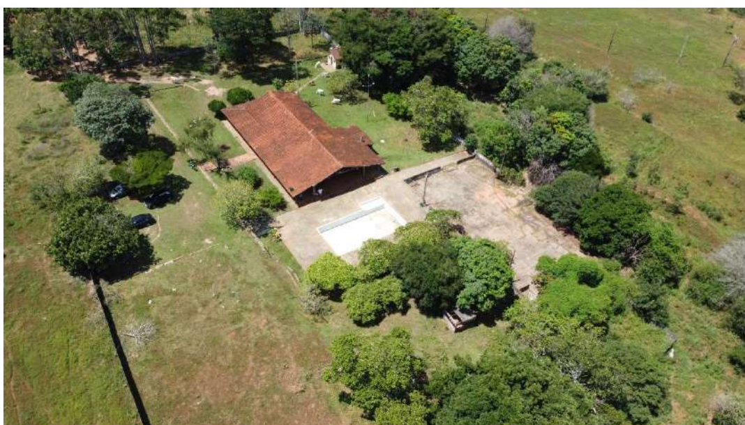
Foto 15 – Vista do Imóvel Avaliando 2.
