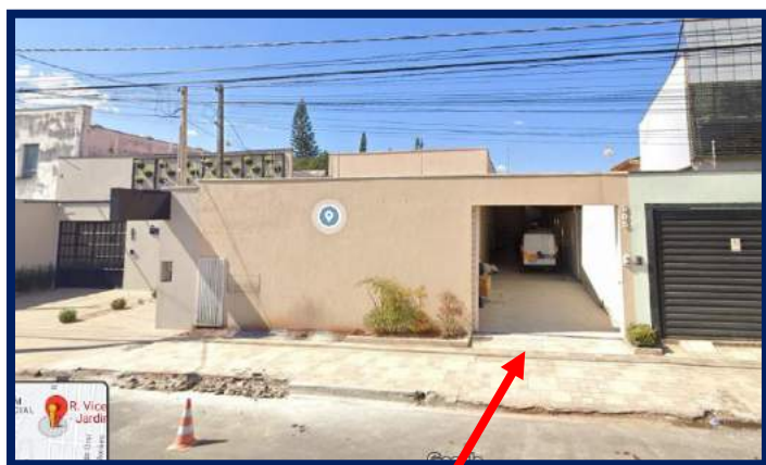
PORTÃO PARA ACESSO DE VEÍCULOS (2018-2019 – LADO DIREITO)
