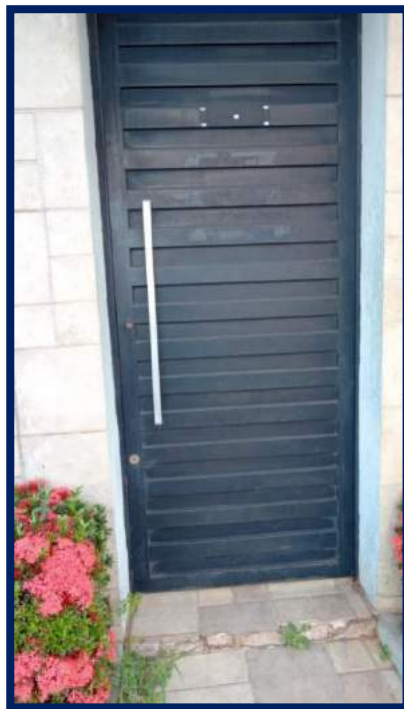
Portão para acesso de pedestres (Lote nº 7).
