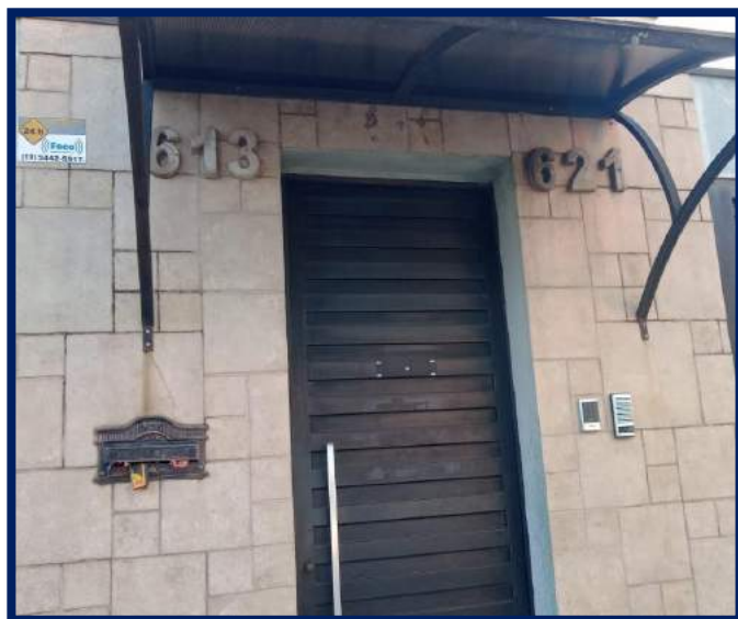
Numeração predial do imóvel, controle para entrada e abertura do portão automático e interfone (em funcionamento) – Lote nº 08.
