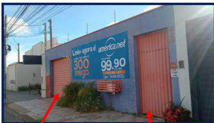
PORTÃO PARA ACESSO DE VEÍCULOS (2023 – LADO ESQUERDO)
