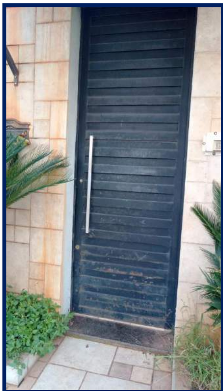
Portão para acesso de pedestres (Lote nº 8).
