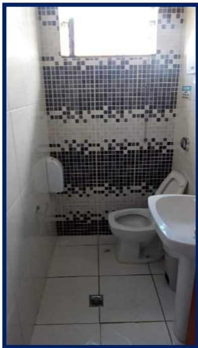
SANITÁRIOS DO PISO SUPERIOR (LOTE Nº 08).
