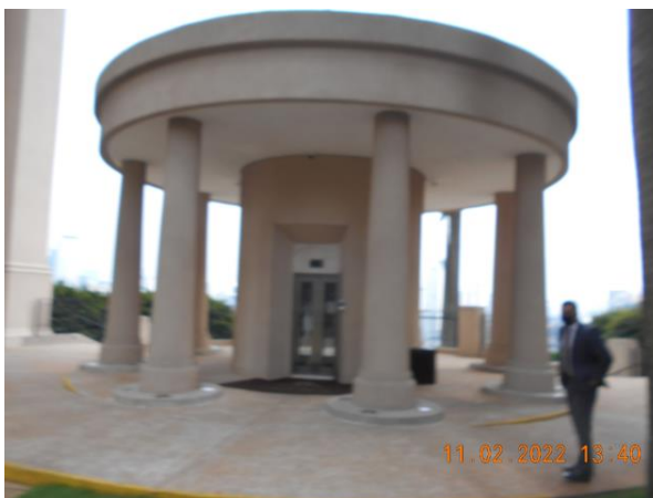
Foto 03 - Vista parcial do elevador que dá acesso direto ao Shopping Cidade Jardim
