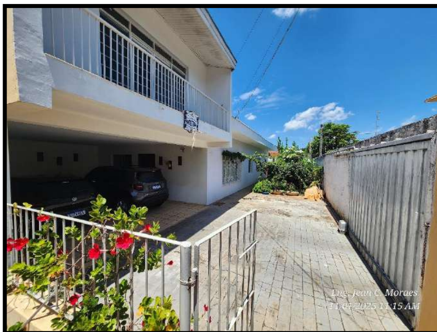
Foto: Imóvel avaliando. Rua Pedreira, 190 (englobo lotes 12 e 14 da quadra 18), Jardim Santo Antônio, Mogi Guaçu-SP.
