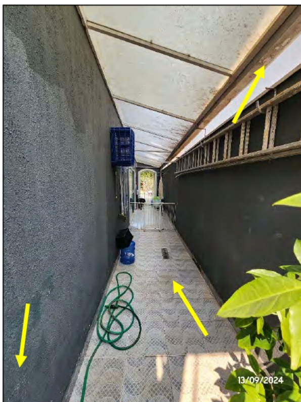
FOTOGRAFIAS Nº 03 E Nº 04: Vista dos corredores laterais. Detalhe das trincas e manchas no revestimento do piso e alvenaria.
