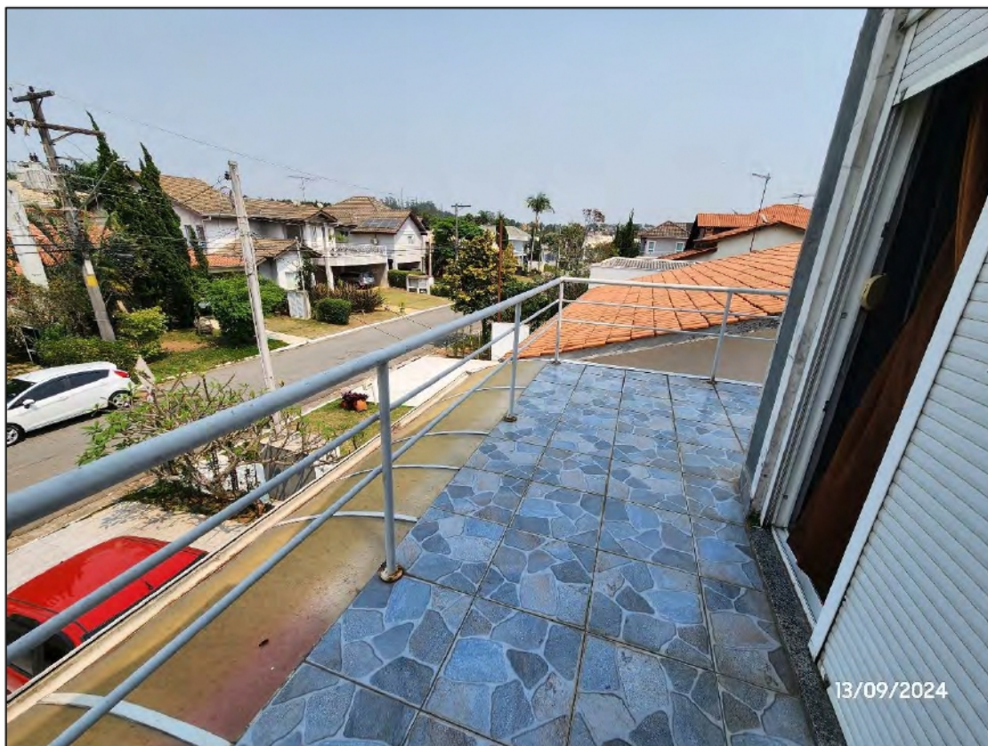
FOTOGRAFIA N° 23: Vista geral da varanda - dormitório 3.
