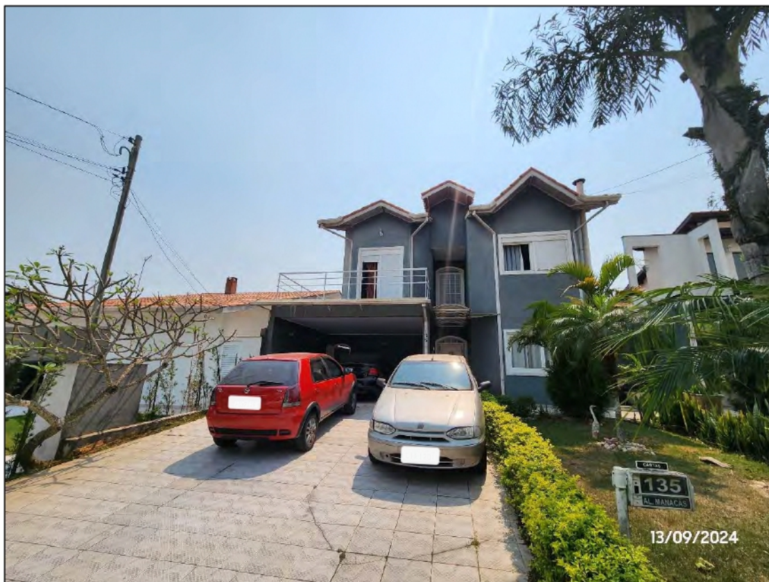
FOTOGRAFIA Nº 02: Vista frontal da edificação. Detalhe das trincas no revestimento do piso.
