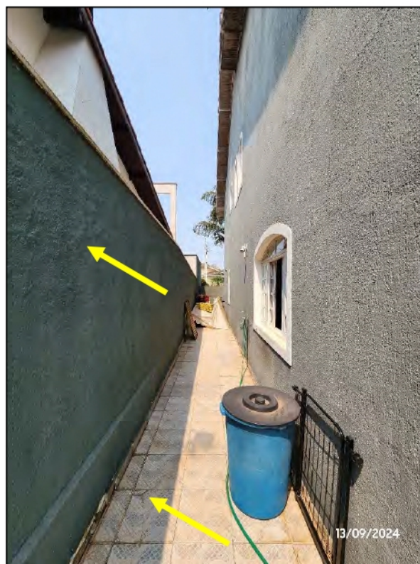
FOTOGRAFIAS Nº 03 E Nº 04: Vista dos corredores laterais. Detalhe das trincas e manchas no revestimento do piso e alvenaria.
