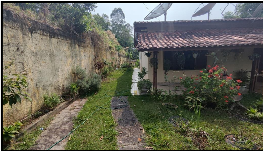
Figura 10: Vista de acesso aos fundos do imóvel avaliado.
