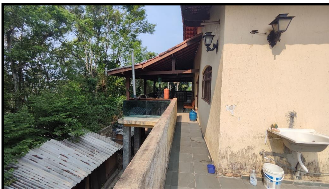
Figura 25: Vista externa do imóvel
