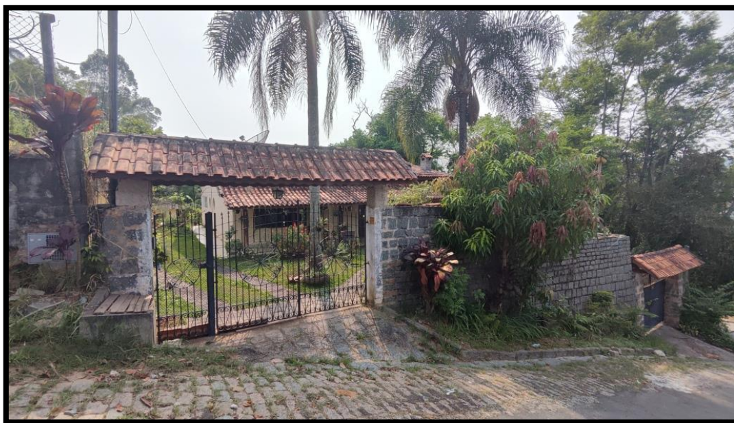
Figura 6: Vista da fachada do imóvel avaliado.
