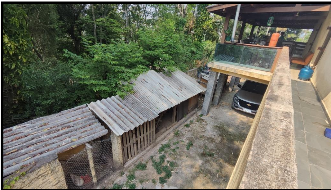
Figura 26: Vista externa do imóvel
