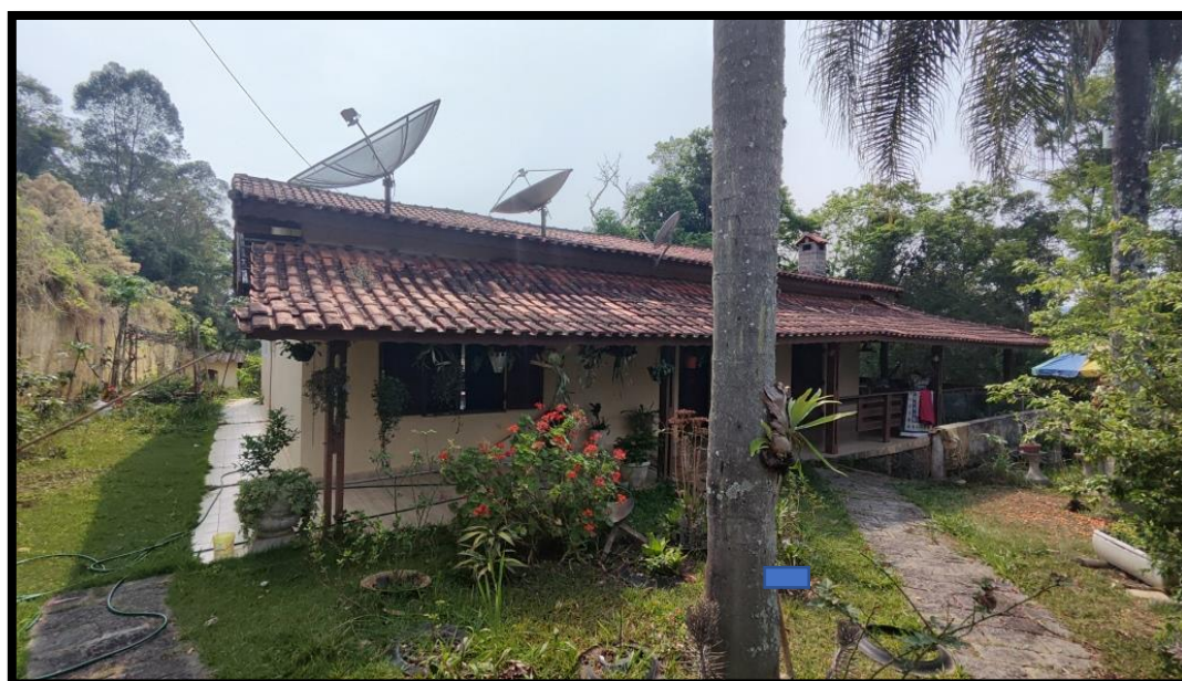
Figura 9: Vista da fachada do imóvel avaliado.
