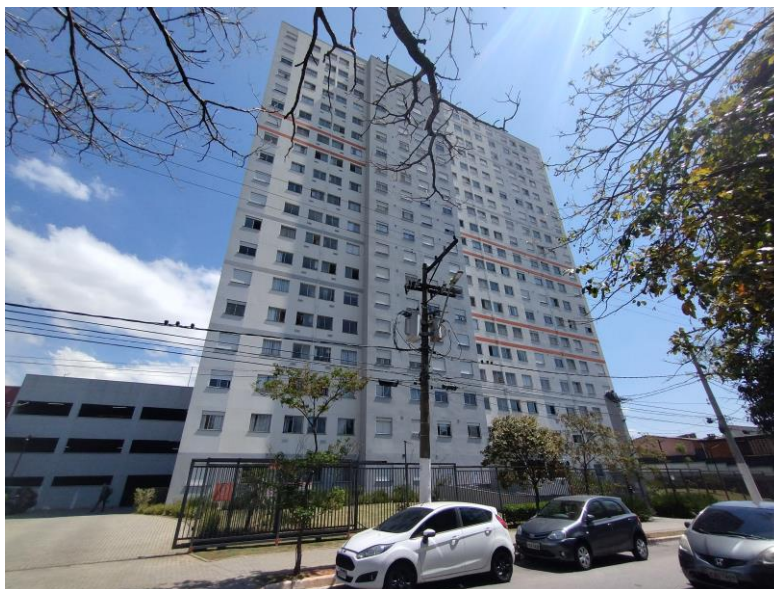
Foto 1 – Vista da Fachada Frontal – Av. Prof. Edgar Santos
