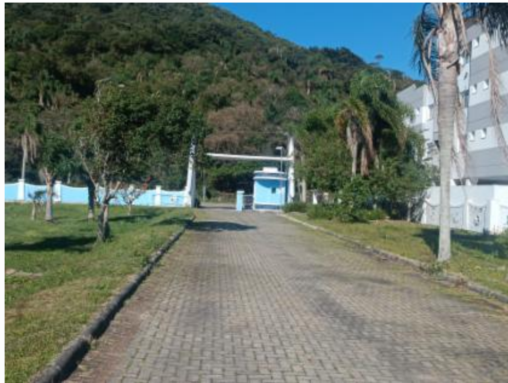
Rua interna do Condomínio
