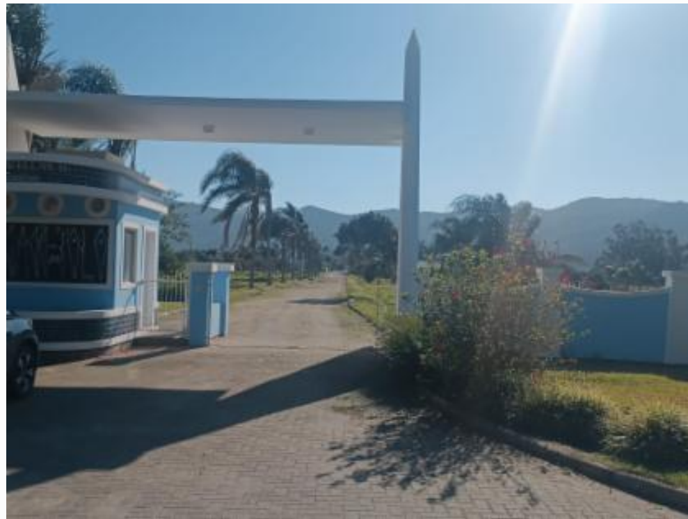
Fachada do Condomínio Condomínio Caravellas Residence II
