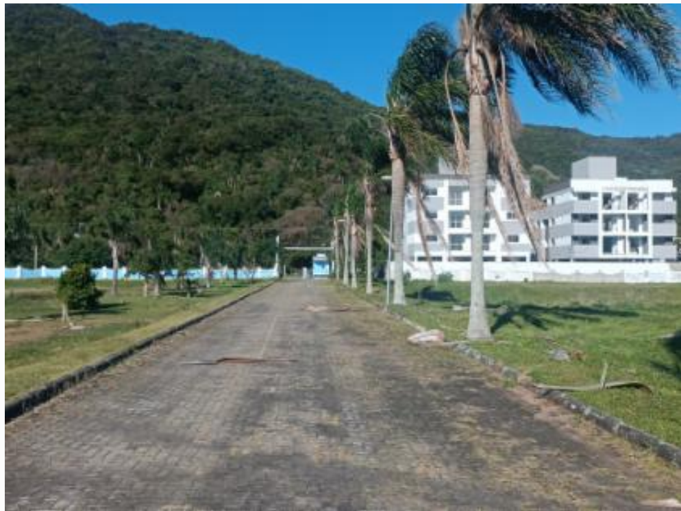
Rua interna do Condomínio
