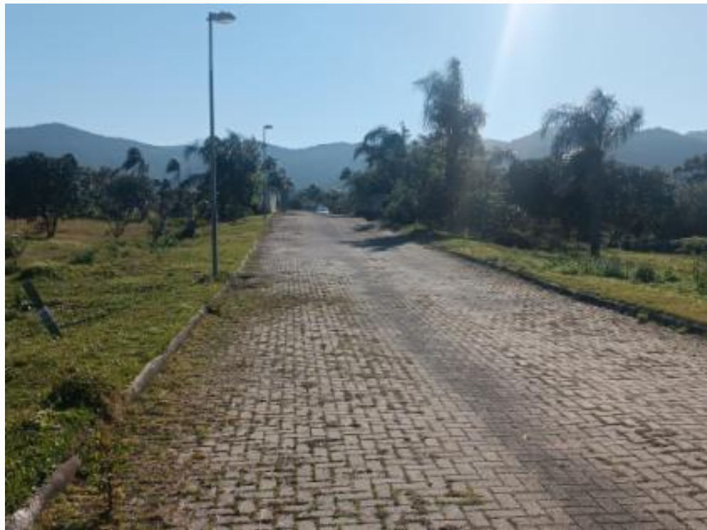
Rua interna do Condomínio
