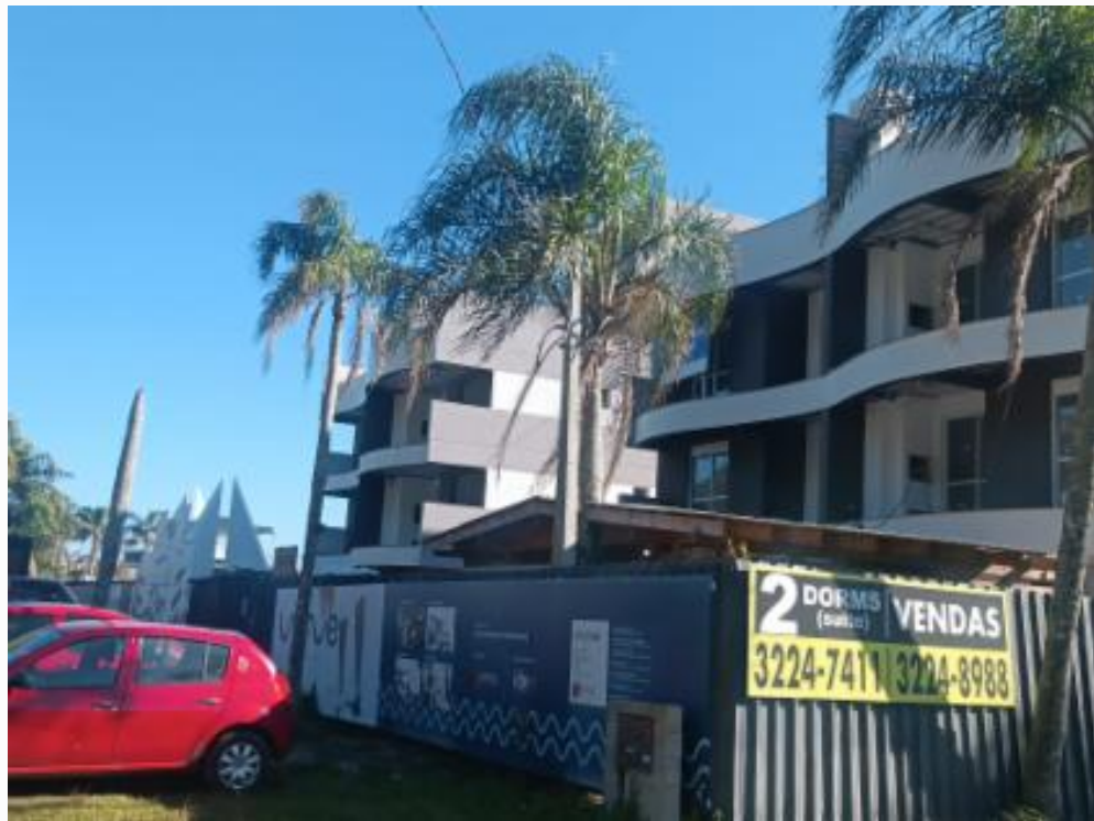
Fachada vizinho lado esquerdo - construção
