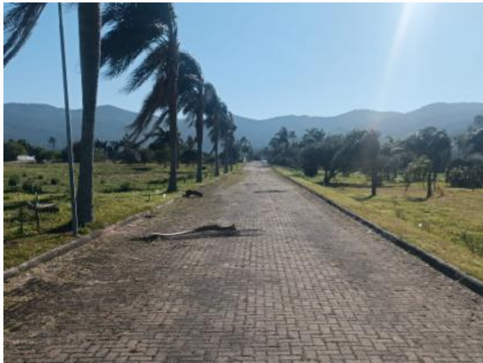
Rua interna do Condomínio
