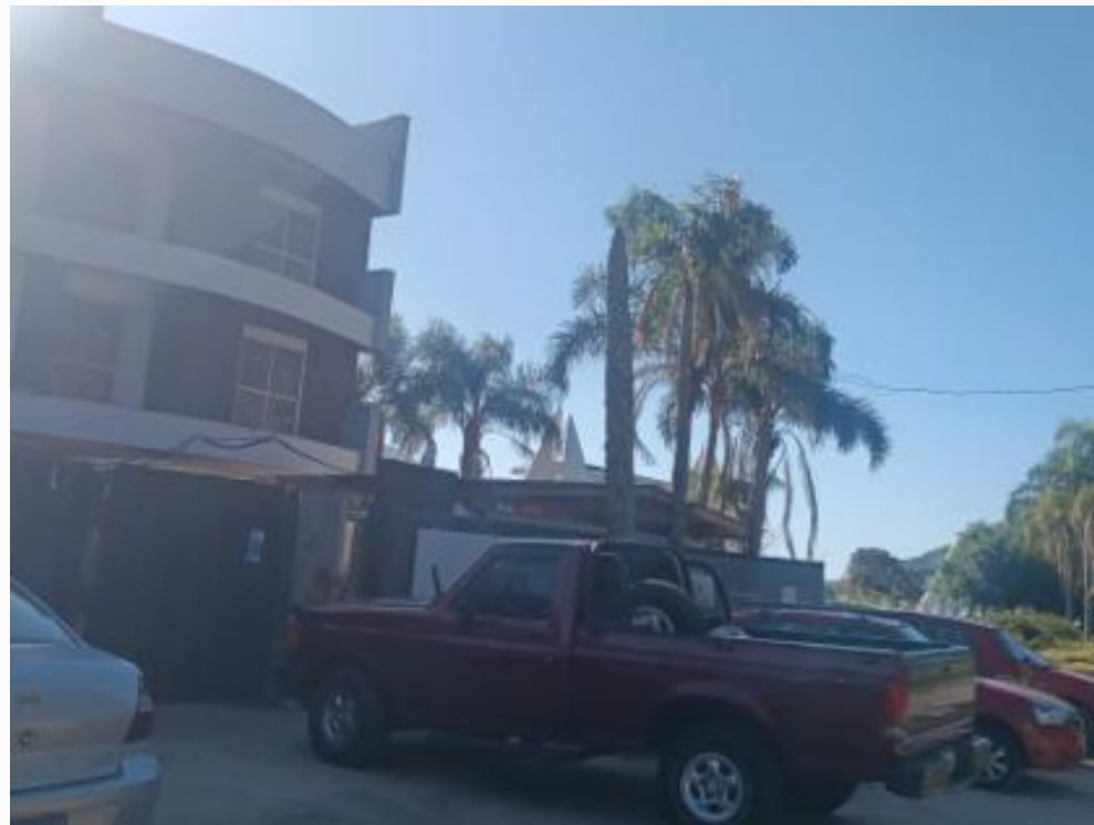
Fachada vizinho lado esquerdo
