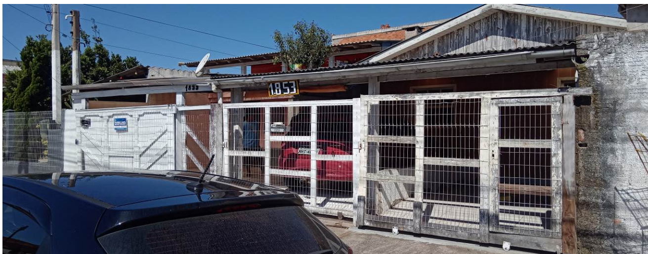
Foto 01 – Fachada do imóvel periciado
