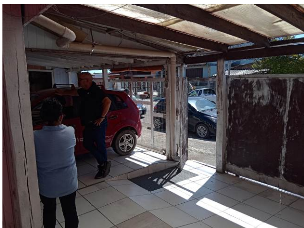
Foto 04 – Garagem da frente dos imóveis
