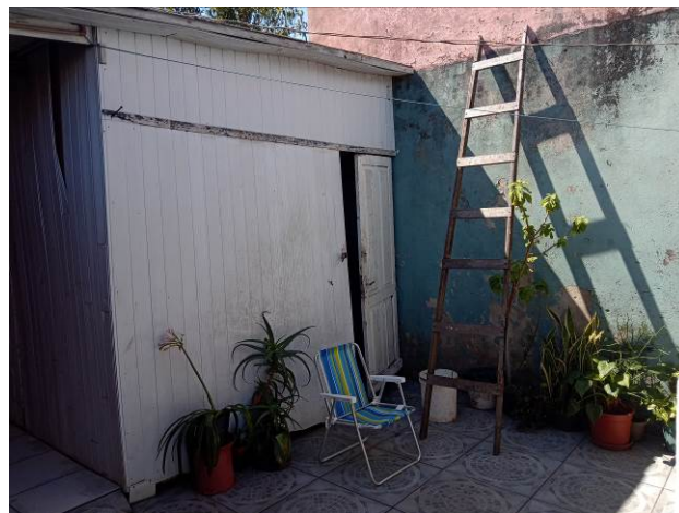
Foto 11 – Anexo visto dos fundos
