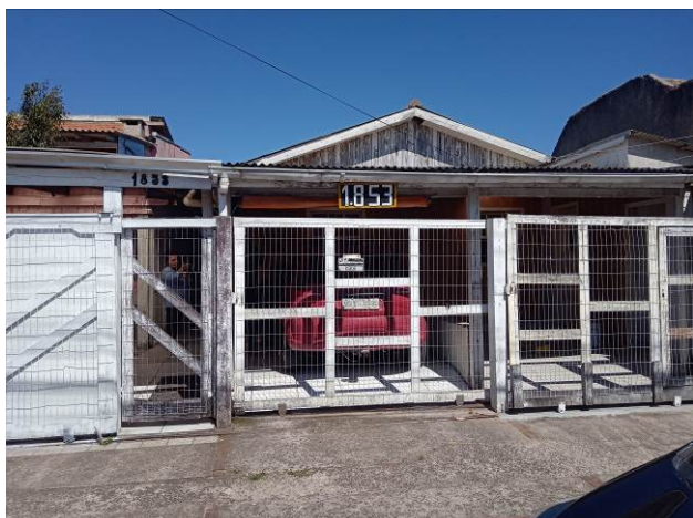
Foto 02 – Fachada do imóvel periciado
