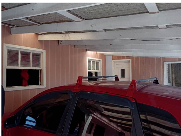
Foto 12 – Frente do imóvel desocupado
