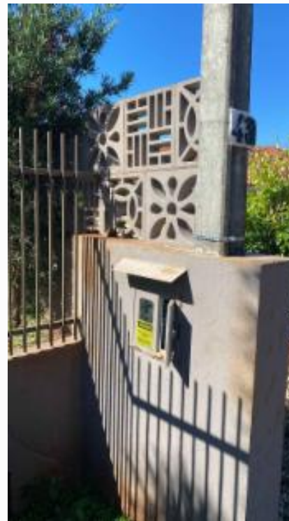
Identificação do avaliando e Medidor de energia
