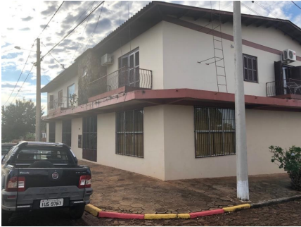
Representação Fachada Descrição Data Foto 04/05/2020
