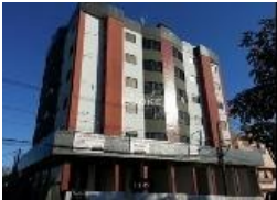
Representação Fachada Descrição Data Foto 04/05/2020
