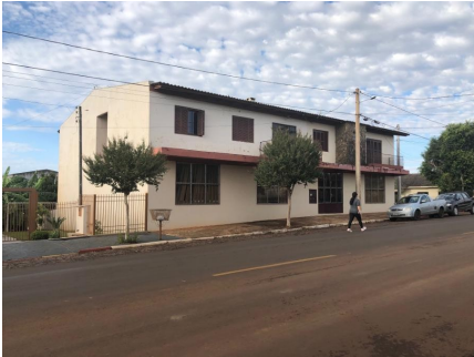
Representação Fachada Descrição Data Foto 04/05/2020
