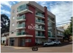
Representação Fachada Descrição Data Foto 04/05/2020
