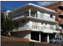
Representação Fachada Descrição Data Foto 04/05/2020
