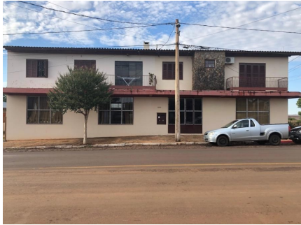
Representação Fachada Descrição Data Foto 04/05/2020
