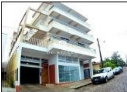
Representação Fachada Descrição Data Foto 04/05/2020
