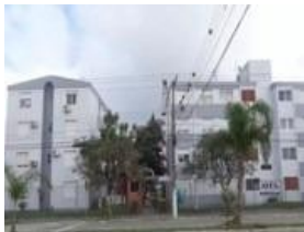
Representação Fachada Descrição Data Foto 27/05/2019
