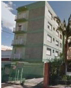
Representação Fachada Descrição Data Foto 27/05/2019
