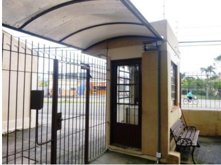
Representação Fachada Descrição Data Foto 23/05/2019
