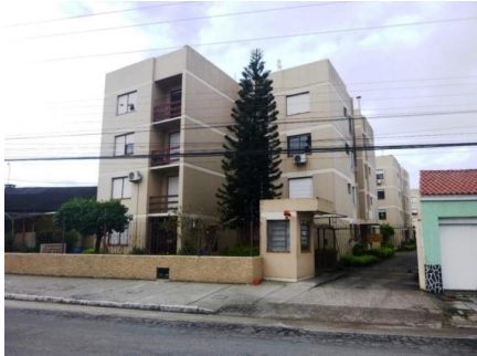
Representação Fachada Descrição Data Foto 23/05/2019
