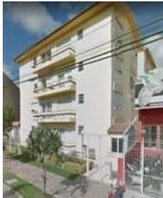
Representação Fachada Descrição Data Foto 27/05/2019
