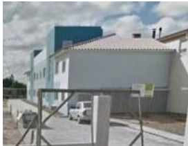
Representação Fachada Descrição Data Foto 27/05/2019
