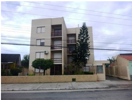
Representação Fachada Descrição Data Foto 23/05/2019
