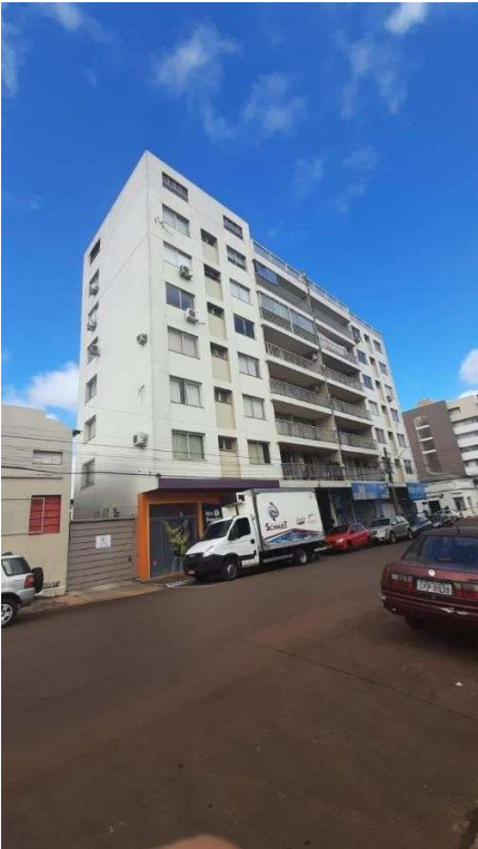
Representação Vista da Rua Descrição Data Foto 11/08/2021
