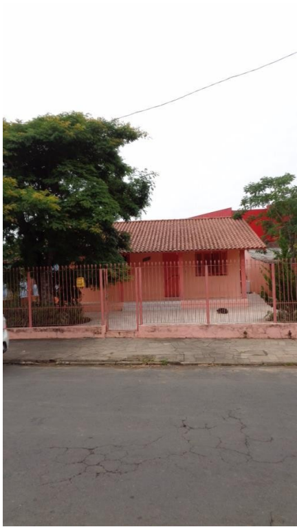
Representação Fachada Descrição Data Foto 07/11/2017
