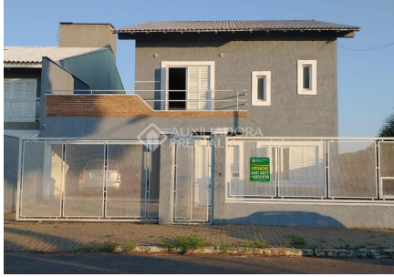
Representação Fachada Principal Descrição Data Foto
