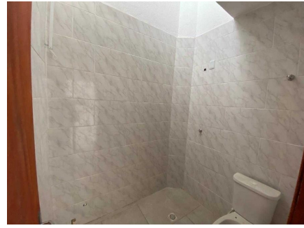
Representação Banheiro social Descrição Data Foto 18/06/2021
