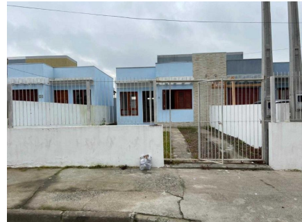
Representação Fachada Principal Descrição Data Foto 18/06/2021
