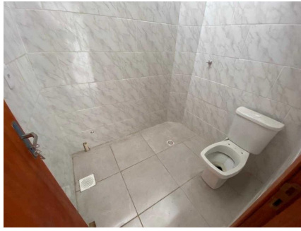
Representação Banheiro social Descrição Data Foto 18/06/2021
