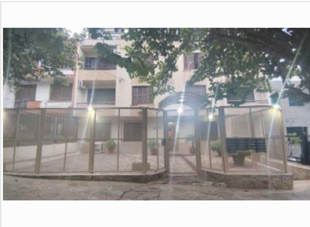
Fachada do Condomínio
