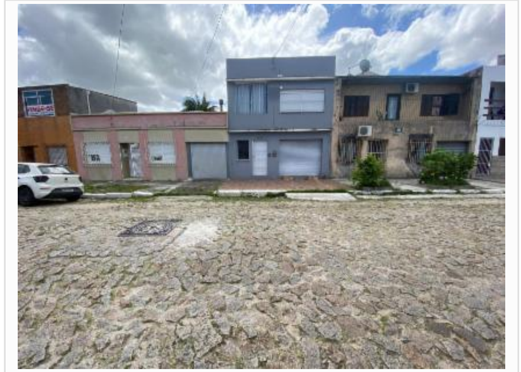
vista da fachada
