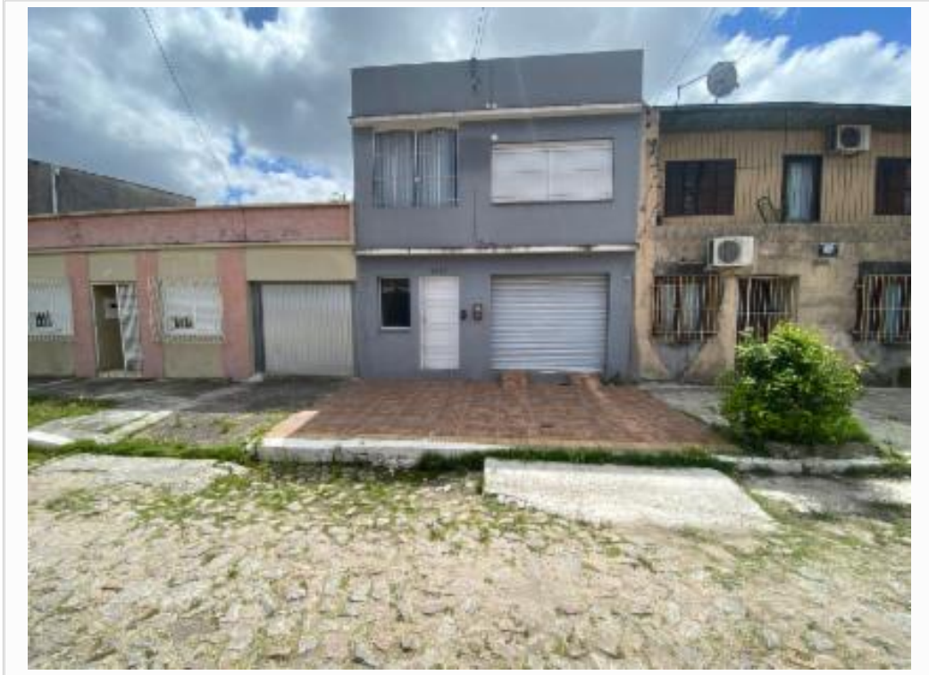
vista da fachada
