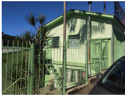
Representação Fachada Principal Descrição Data Foto 12/05/2021
