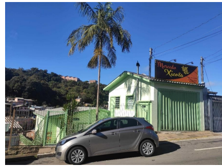
Representação Fachada Principal Descrição Data Foto 12/05/2021
