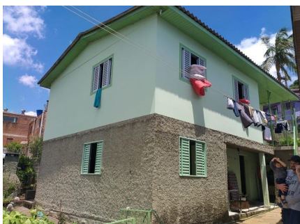
Representação Fachada Descrição Data Foto 06/12/2019
