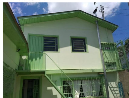
Representação Fachada Descrição PELA RUA SERGIO ANTONIO GOBETE Data Foto 06/12/2019
