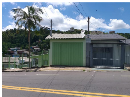
Representação Fachada Descrição PELA RUA SERGIO ANTONIO GOBETE Data Foto 06/12/2019
