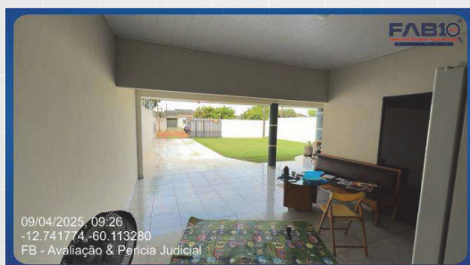
VISTA DA VARANDA/GARAGEM PARA PORTÃO DE ACESSO
