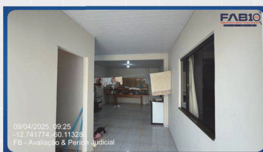
VISTA DO STANDAL PARA ÁREA DE SERVIÇO
