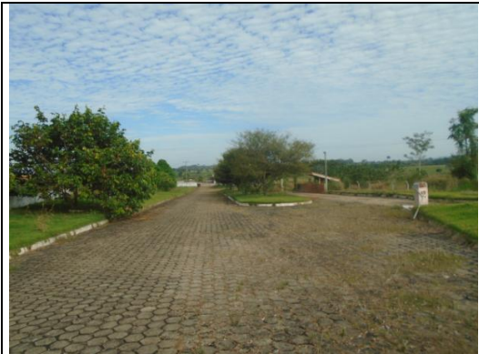
Foto 01 – Entrada do Imóvel – Lajotas
