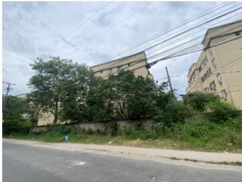
FACHADA CONDOMINIO PELA RUA MURILO ALVARENGA
