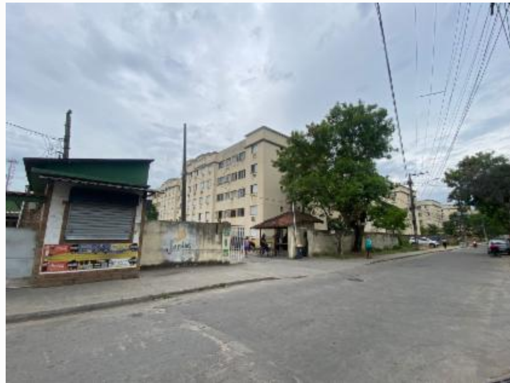
FACHADA CONDOMINIO PELA RUA GENTIL DE OURO
