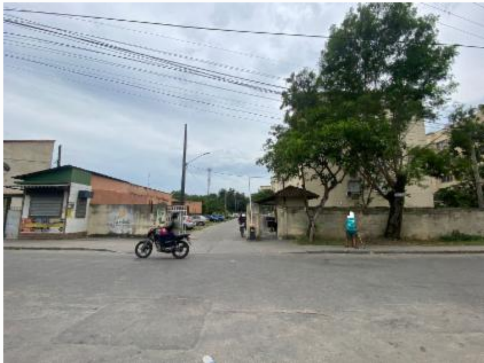
FACHADA CONDOMINIO PELA RUA GENTIL DE OURO
