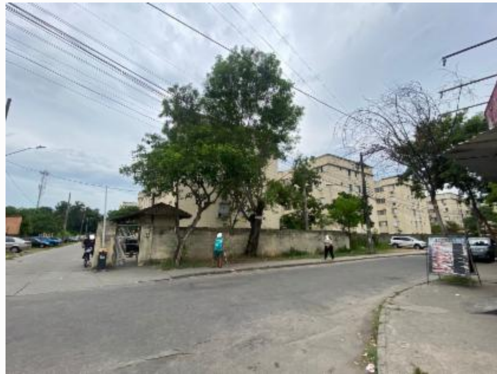
FACHADA CONDOMÍNIO PLE ARUA GENTIL DE OURO
