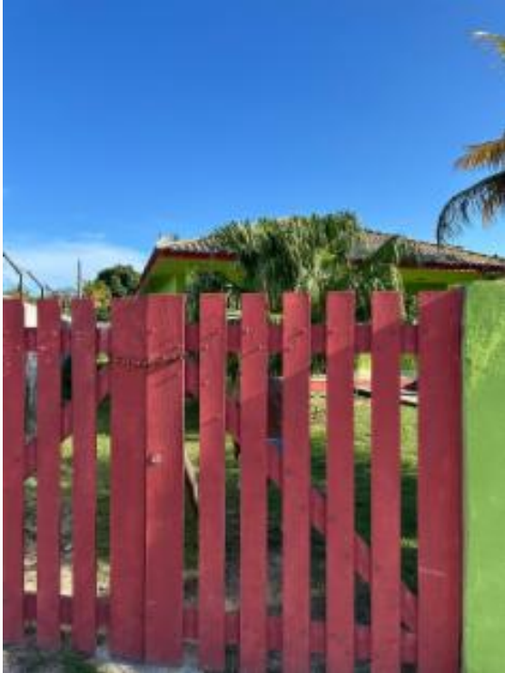
vista parcial da fachada interna
