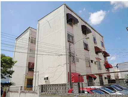
Representação Fachada Principal Descrição Data Foto 24/09/2020
