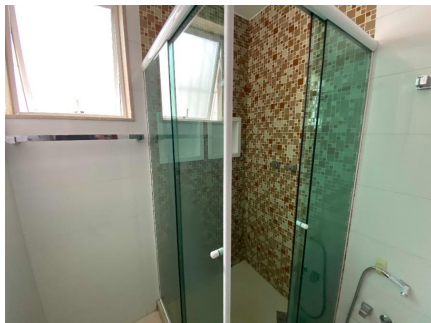
Representação Banheiro Suíte Descrição Data Foto 09/06/2021
