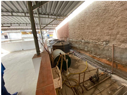
Representação Descrição Medidor de energia. Data Foto 09/06/2021
