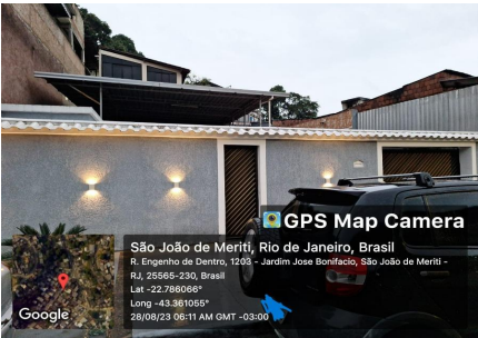
Representação Fachada Principal Descrição Data Foto 28/08/2023
