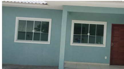
Representação Fachada Principal Descrição Data Foto 05/10/2023
