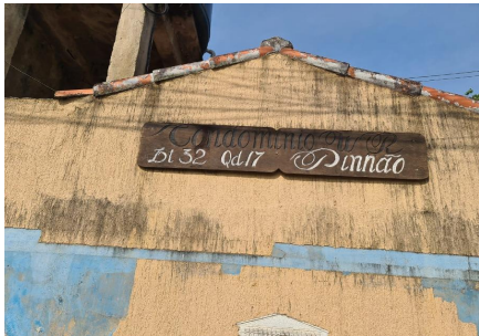
Representação Fachada Principal Descrição Data Foto 05/10/2023
