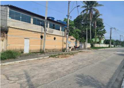
Representação Fachada Principal Descrição Data Foto 05/10/2023
