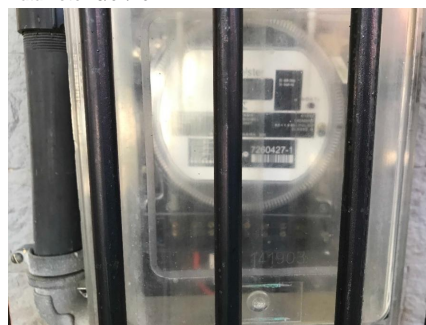
Representação Descrição Medidores Data Foto 18/01/2022
