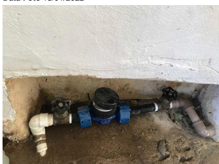
Representação Descrição Medidores Data Foto 18/01/2022
