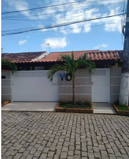
Representação Fachada Principal Descrição Data Foto 24/04/2023
