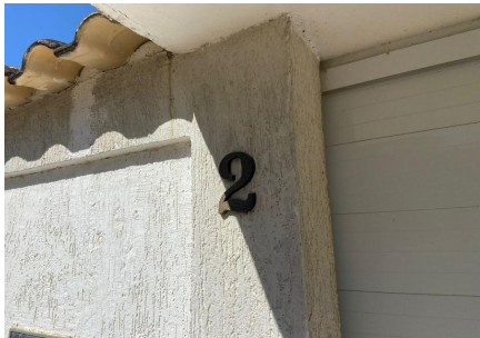
Representação Identificação Numérica Descrição Identificação vizinho Data Foto 24/04/2023
