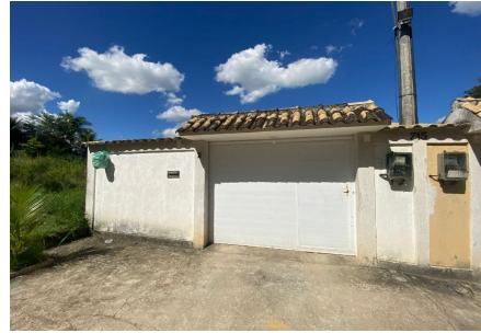
Representação Fachada Principal Descrição Fachada vizinho Data Foto 24/04/2023
