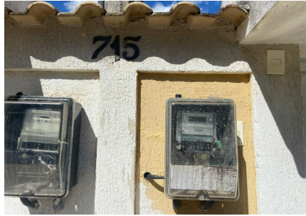
Representação Identificação Numérica Descrição Medidor Data Foto 24/04/2023
