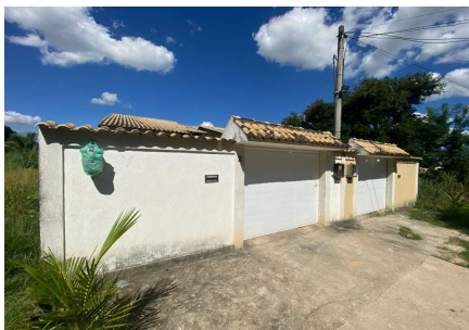
Representação Fachada Principal Descrição Data Foto 24/04/2023
