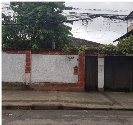
Representação Fachada Principal Descrição Data Foto 15/05/2023
