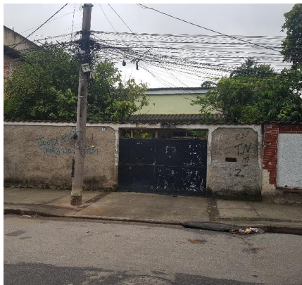
Representação Vista da Rua Descrição Data Foto 15/05/2023
