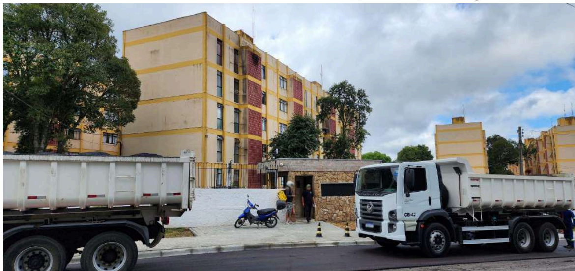
Vista do Imóvel Avaliando
