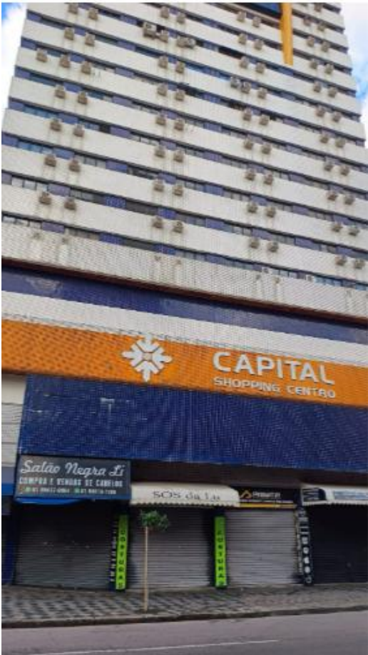
Fachada do prédio
