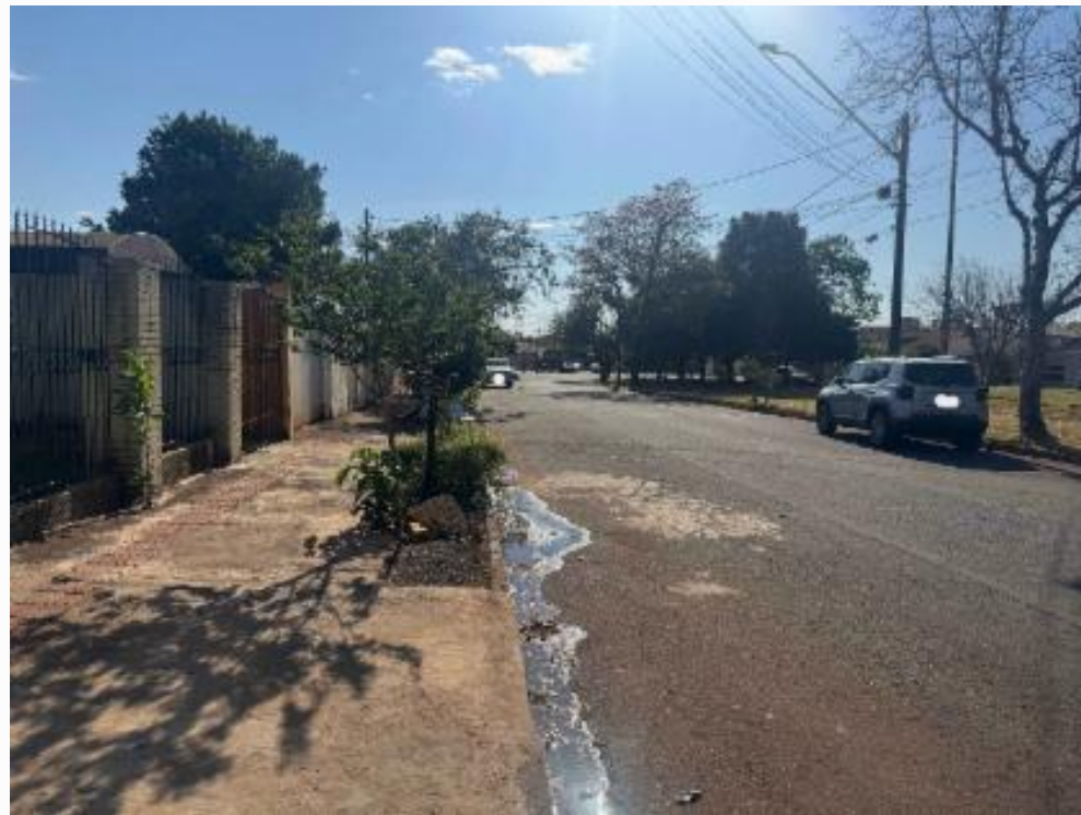
Vista da rua à esquerda
