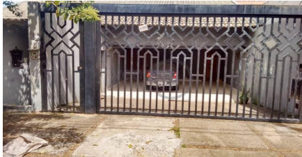
Representação Fachada Principal Descrição Data Foto
