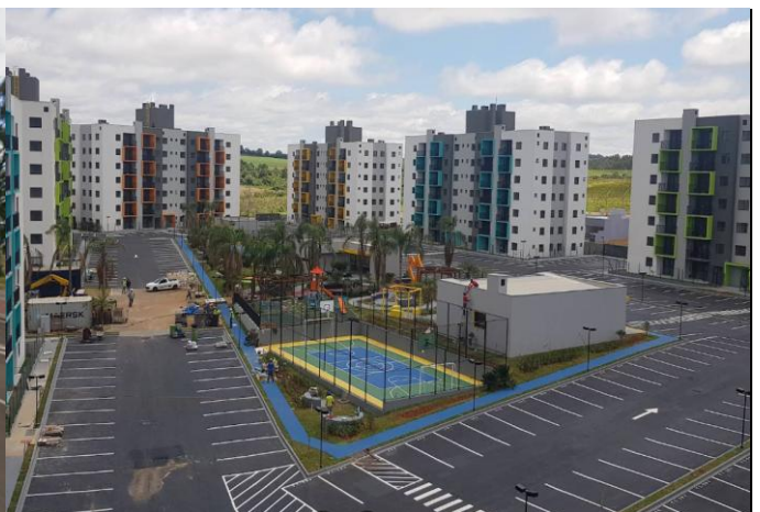
Área comum do condomínio
