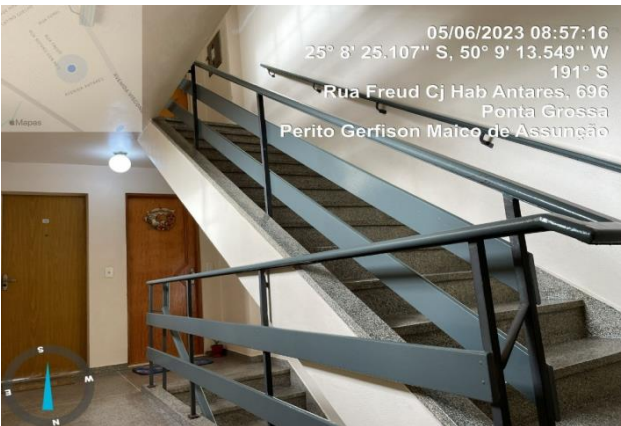
Acesso por escada
