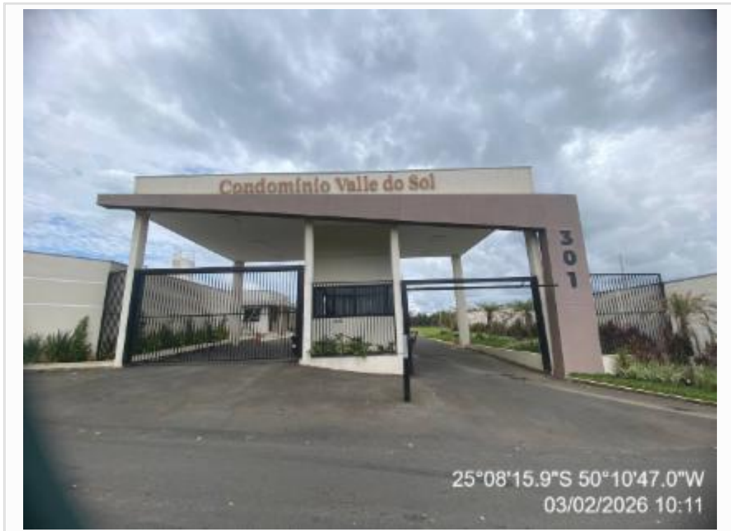
FACHADA DO CONDOMINIO
